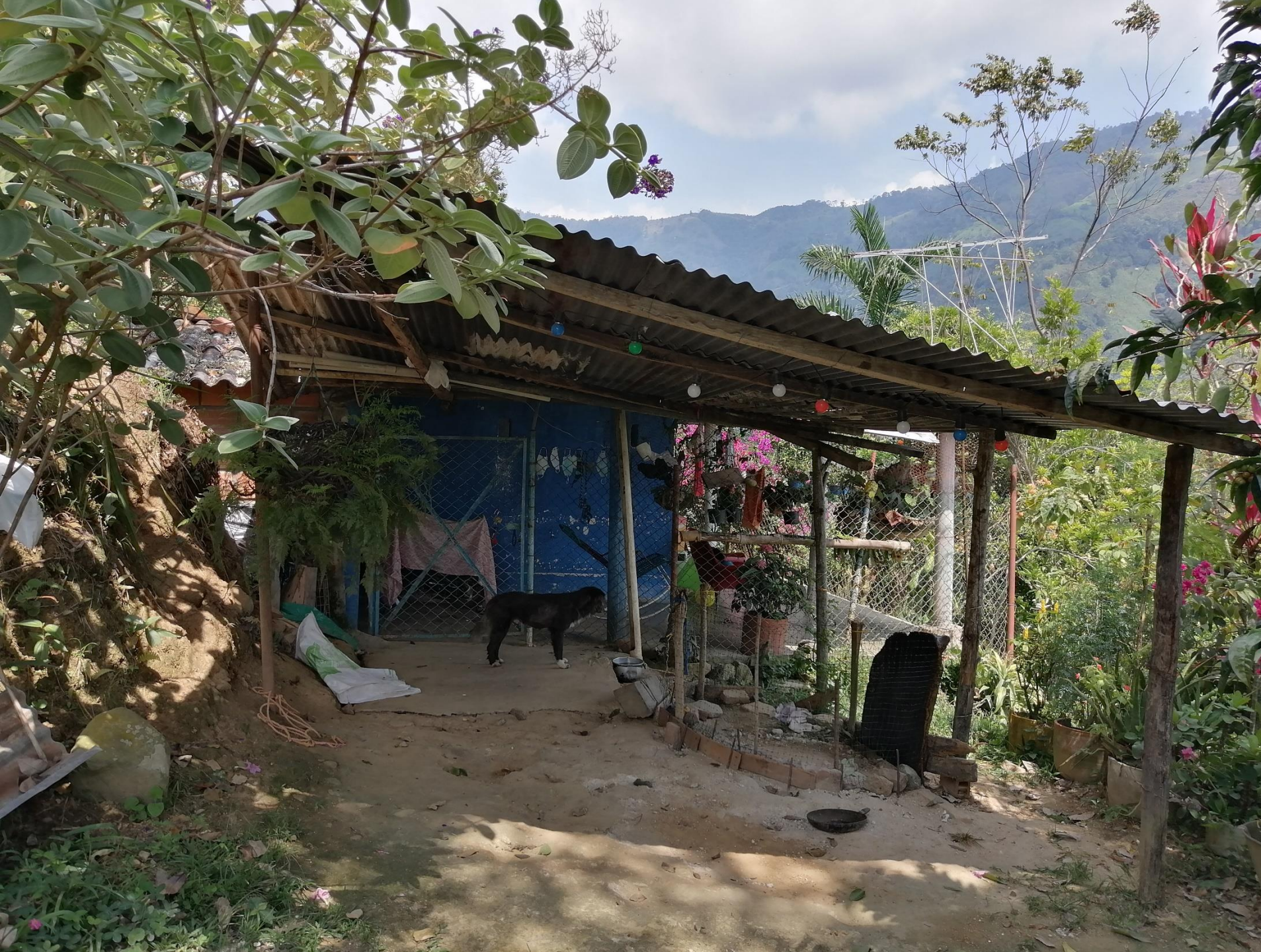
FACHADA DE LA CASA
