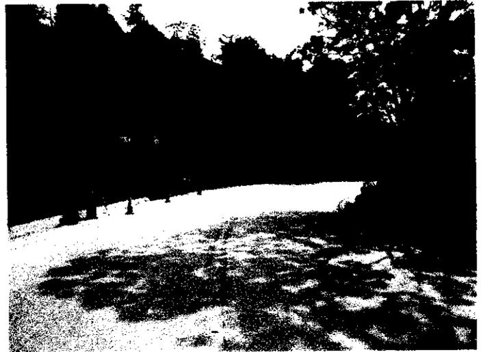
**Fotografía No. 3 y 4.** Sentido Bucaramanga-San Gil. Se observa un tramo vial curvo con radio de curva de 54 metros; peralte de 5,5 y una pendiente de 0,8, carpeta asfáltica en buen estado de conservación, una calzada dos carriles de doble sentido vial; con un campo visual limitado por el diseño de la vía curva y la vegetación en los costados. Sentido vehicular del tracto camión de placas SON 491.
