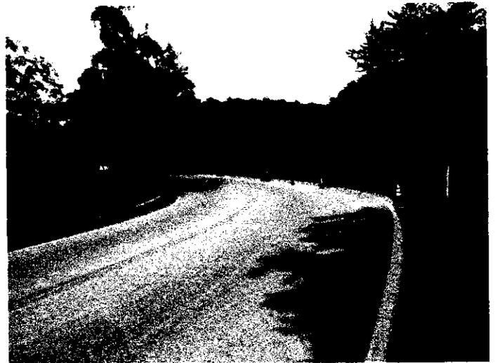
**Fotografía No. 7 y 8.** Sentido San Gil-Bucaramanga. Se observa un tramo vial curvo horizontal a la izquierda, con un radio de 54 metros, un peralte de 5,5, campo visual limitado por el diseño de la curva y la vegetación en los costados, con señalización horizontal líneas de borde y doble línea continua amarilla; con señalización delineadores de curva en el costado derecho; se observa muros de contención en los extremos de la calzada. Sentido vehicular del camión de placas USE 010
