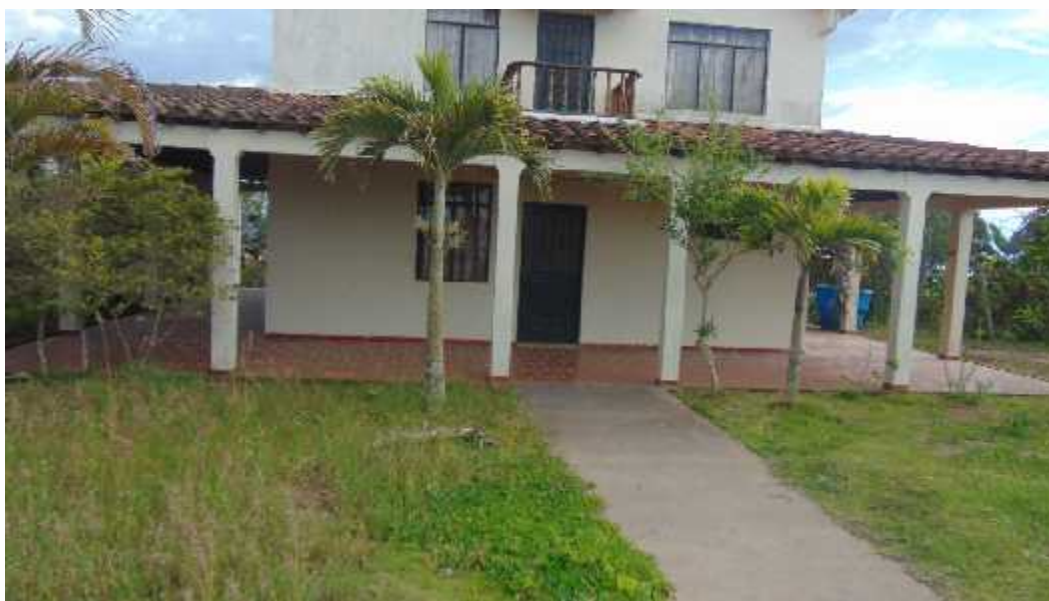
Construcción en el Predio Villa Daniela
