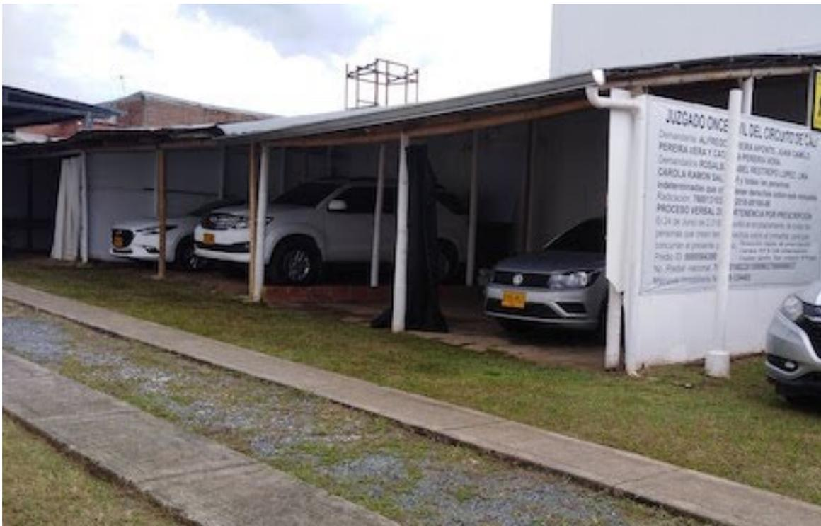
Espacio No 3 evidenciado – Parquedero con cubierta en zinc, estructura metálica, división en fibrocemento con losa de cemento y pared de división con el inmueble vecino. Capacidad para dos vehículos y almacenamiento.
