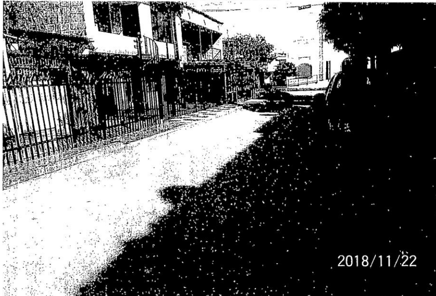
FOTOS DEL AVALUO INTERDICTA CARRERA 20 A No. 50-49 ALAMOS NORTE LINDERACION INMUEBLE
