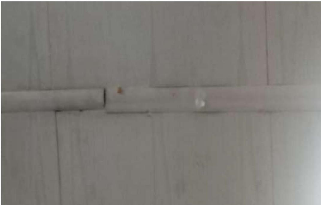
Como se puede observar, el agua se filtraba por el techo del establecimiento de comercio, por ausencia de una cubierta apta para detener las filtraciones.
