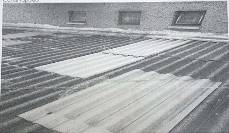
Tejas mal instaladas. están encima de las que estaban. en mal estado
