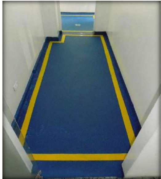
Adecuación / Piso Laboratorio
