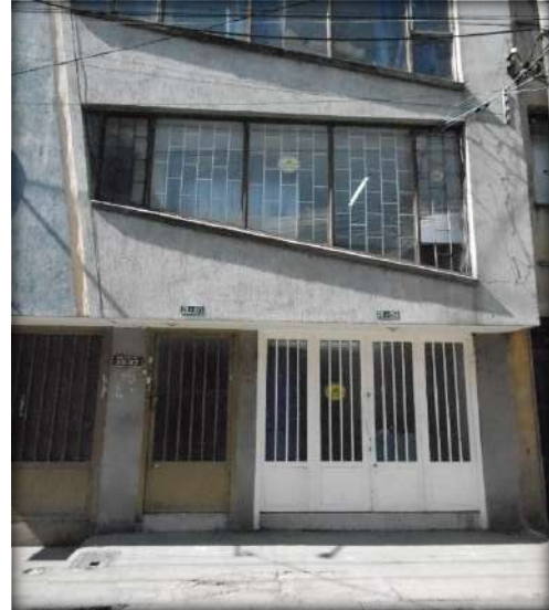
Puerta de Ingreso a Laboratorio
