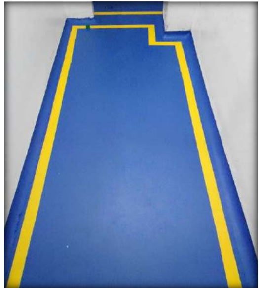
Adecuación / Piso Laboratorio
