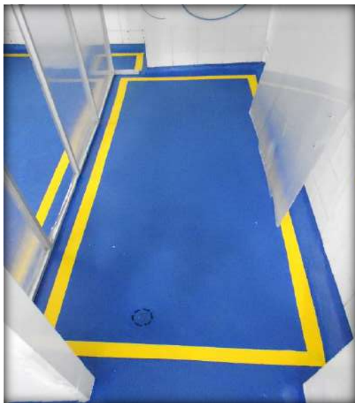
Adecuación / Piso Laboratorio
