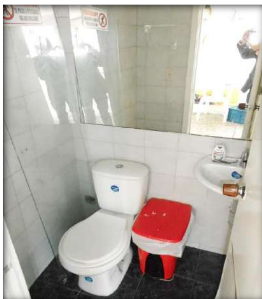
Baño Segundo Piso / Laboratorio
