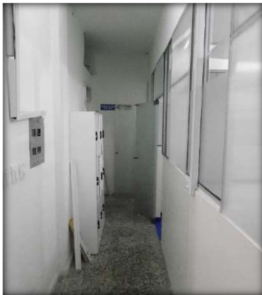
Adecuación / Área Lockers
