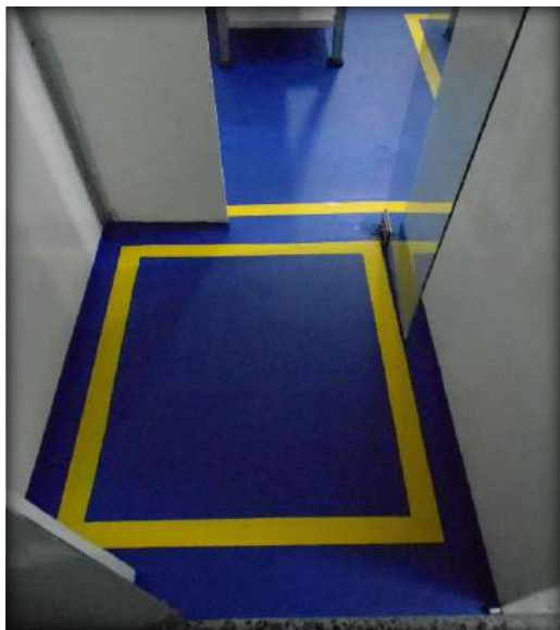
Adecuación / Piso Laboratorio
