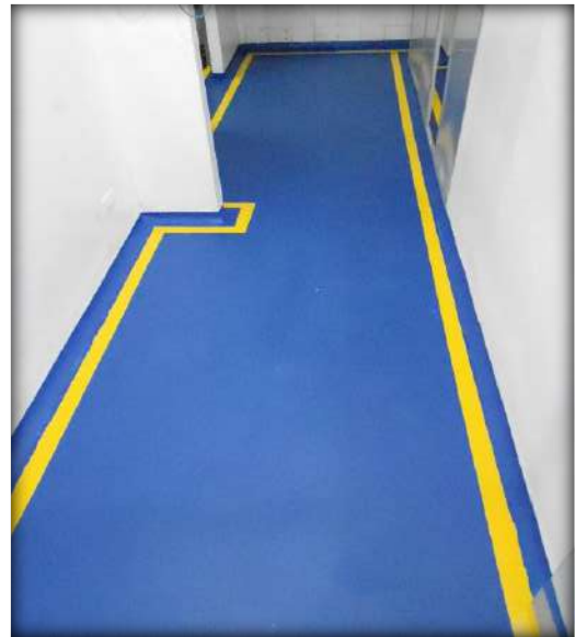
Adecuación / Piso Laboratorio
