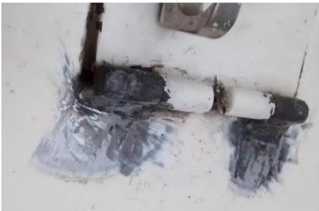
El deterioro de las bisagras de la contrapuerta ocurrió debido a una combinación de factores, incluido el uso normal del inmueble y el desgaste natural de los materiales con el tiempo.
