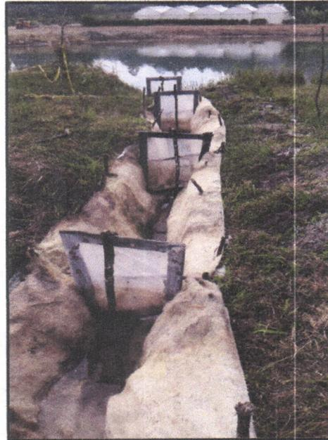
**Fotografía N° 5, 6 Y 7. Celda en recuperación y Filtros para retención de sedimentos**
