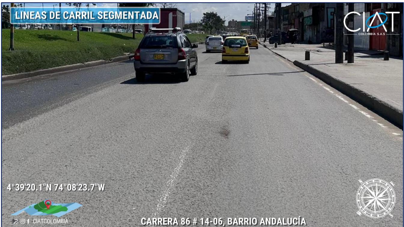
**IMAGEN 5.** En la imagen se aprecia la demarcación “Líneas de carril segmentada”, las cuales se sitúan sobre la carrera 86 # 14-06.
