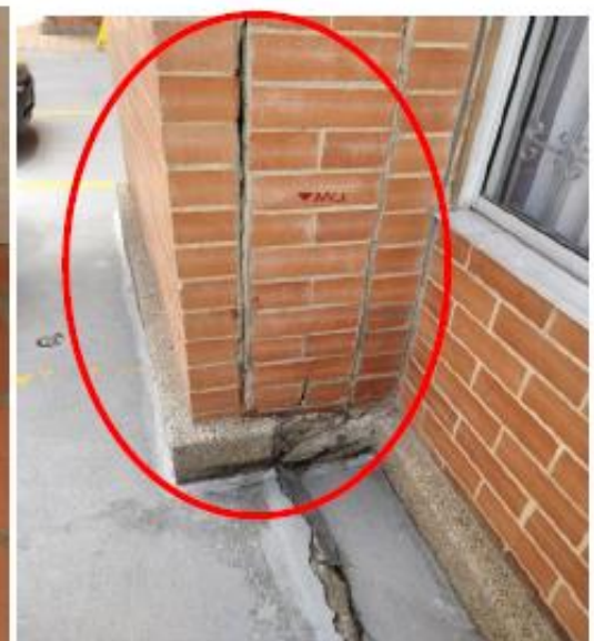
Figura 23 Localización de lesiones en muros intervenidos (Fisuras, Grietas y Desprendimientos)
