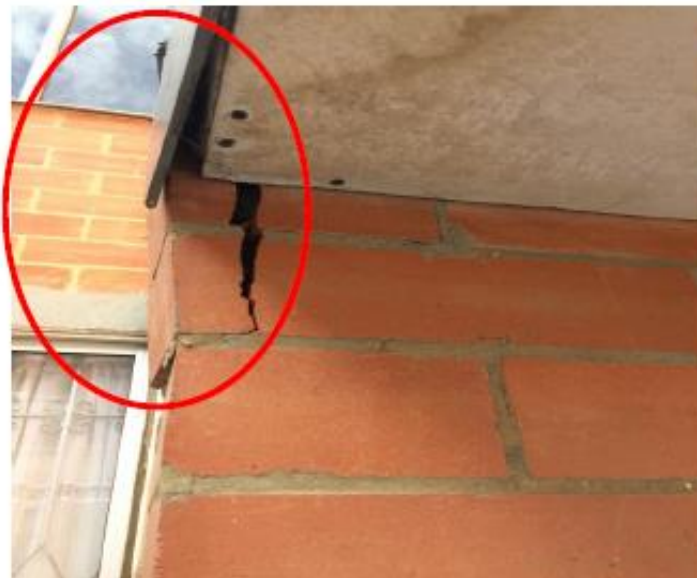
Figura 23 Localización de lesiones en muros intervenidos (Fisuras, Grietas y Desprendimientos)
