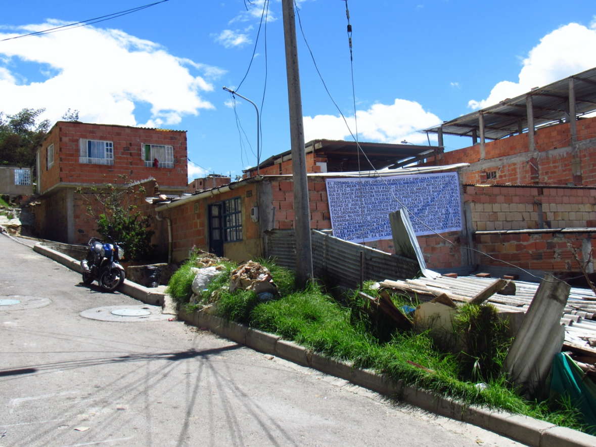
VISTA CALLE 62H SUR
