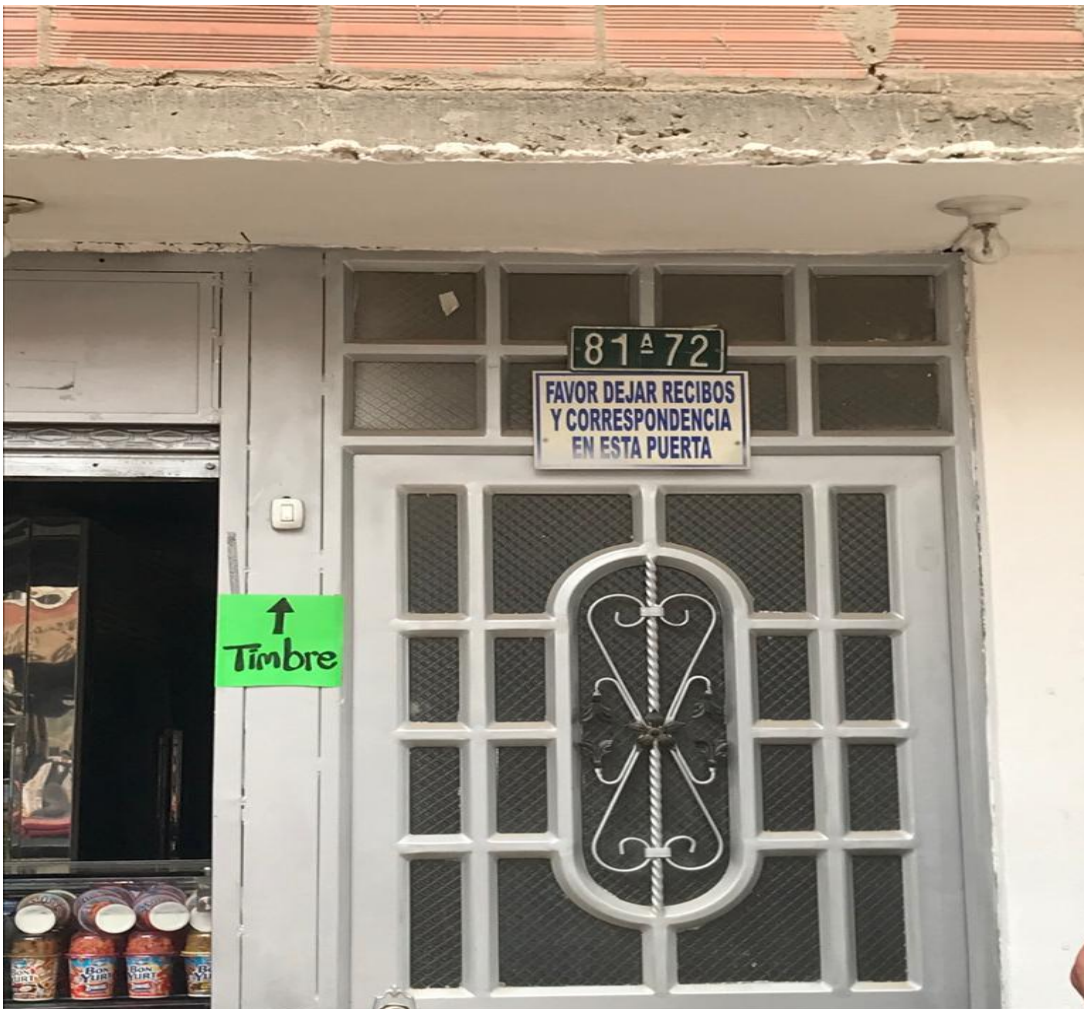
20. Blanca Lilia Varga Parra, predio Calle 57 C SUR N° 81A - 72, instalación de valla no es visible.
