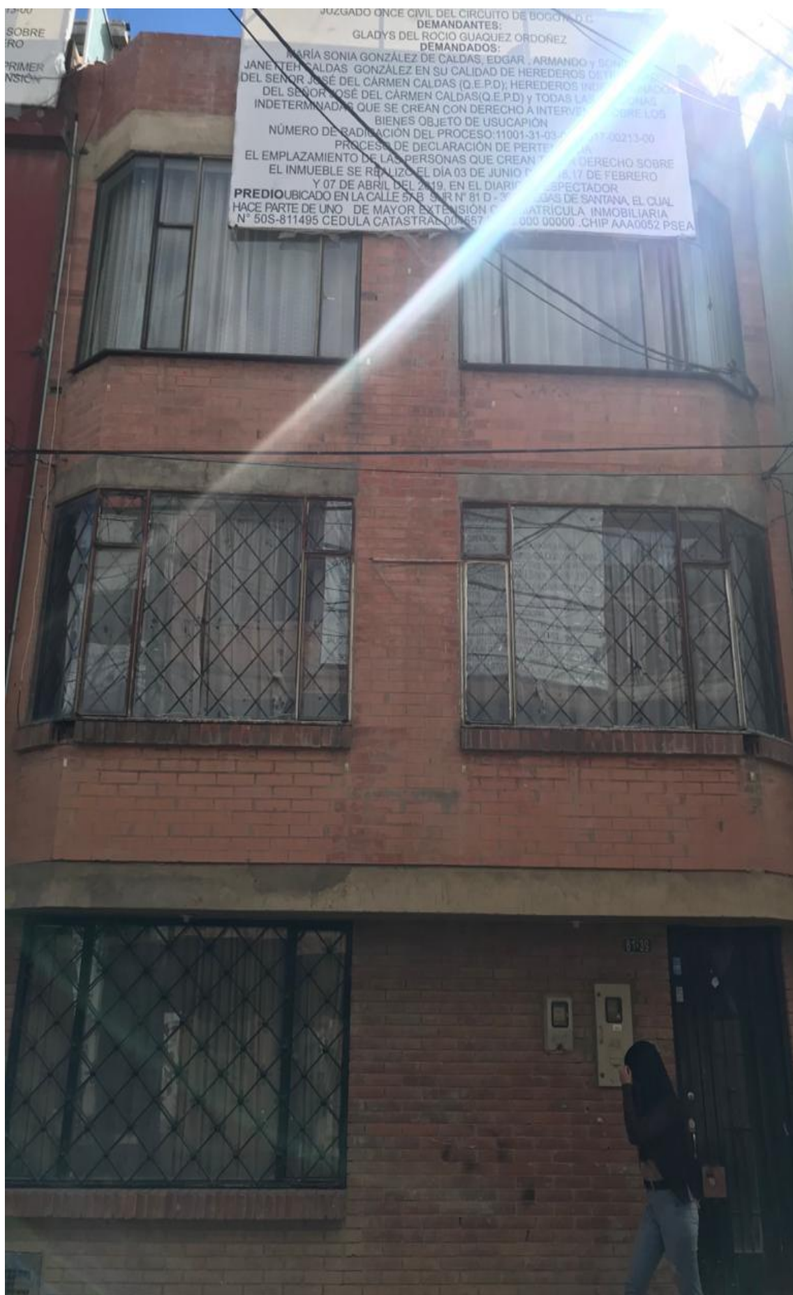
23. Rito Celio Velazco, predio Calle 57 C SUR N° 81A - 50 instalación de valla no es visible.
