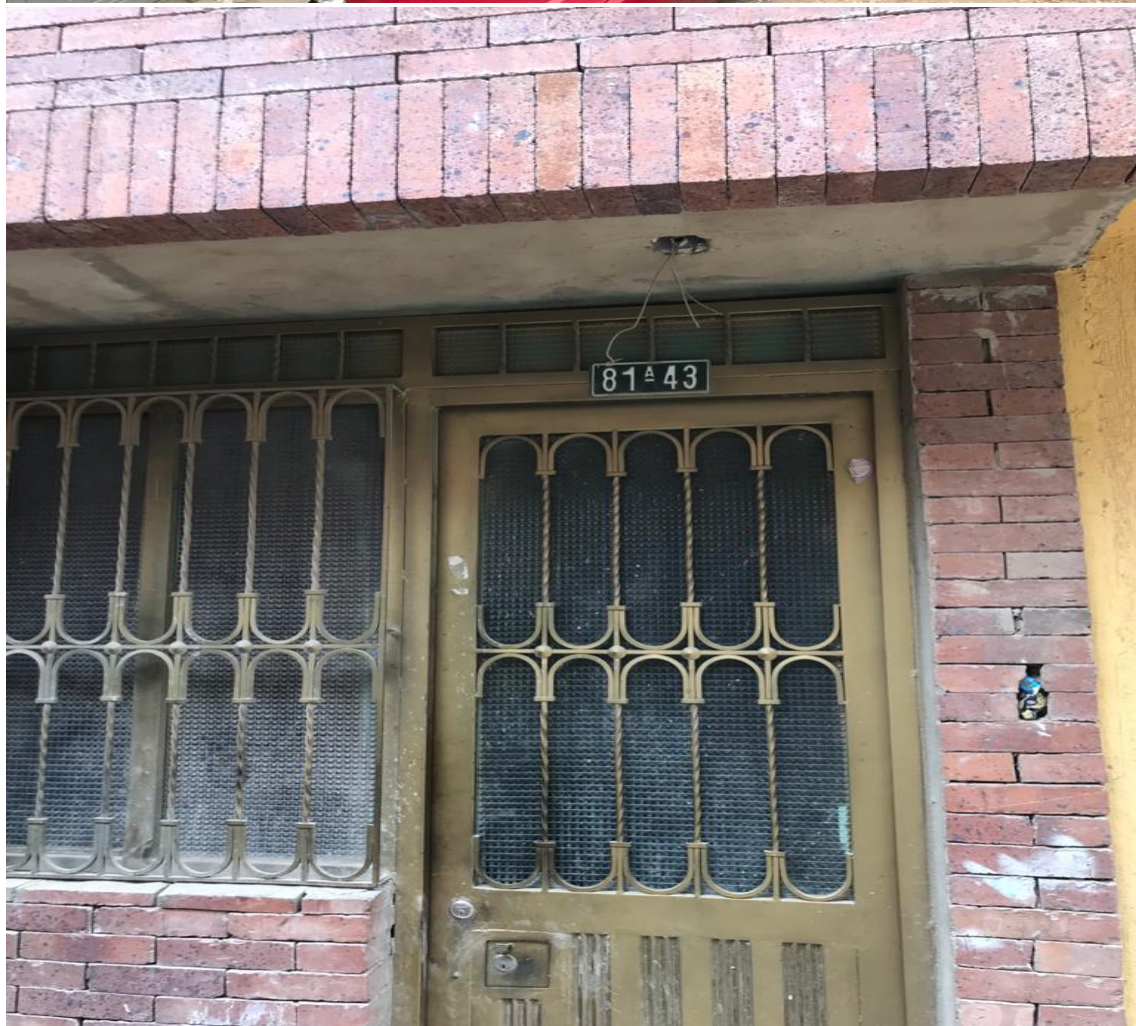
22. Gladys del Rocío Guaquez Ordoñez, predio Calle 57B SUR N° 81D-39 instalación de valla no es visible.
