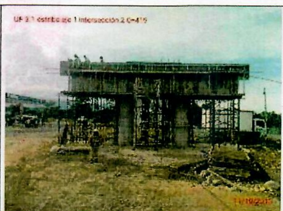
Foto 48. Encofrado de espaldar Eje 1
