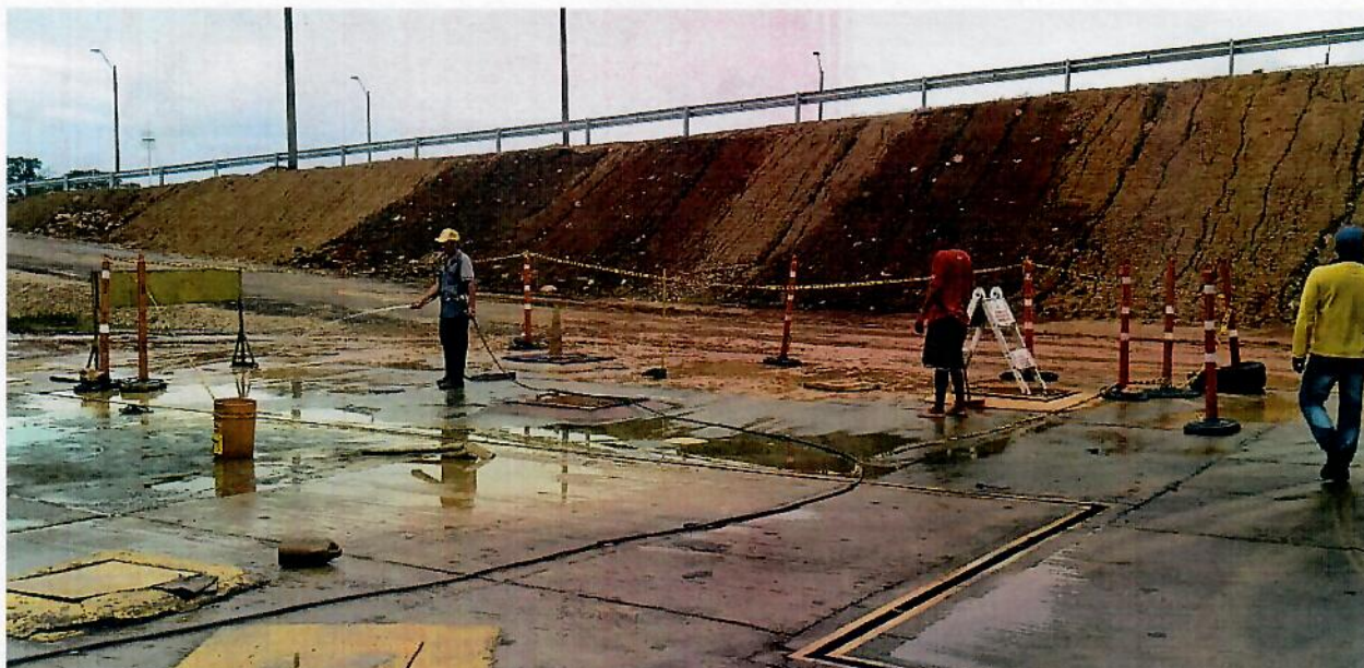
TRABAJOS DE LIMPIEZA Y ADECUACIÓN EN DIAS LLUVIOSOS
