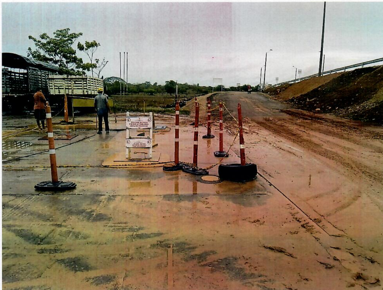
IMAGEN ZONA DESCARGUE Y TANQUES DE COMBUSTIBLE INUNDADA DE LODO Y AGUA
