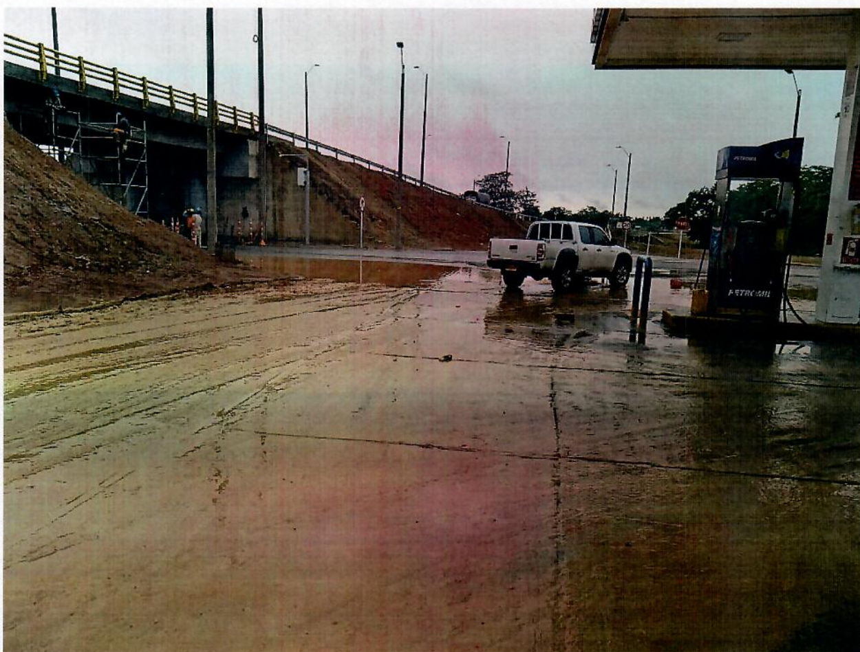
TRANSITO DE VEHICULOS POR CANOPYS
