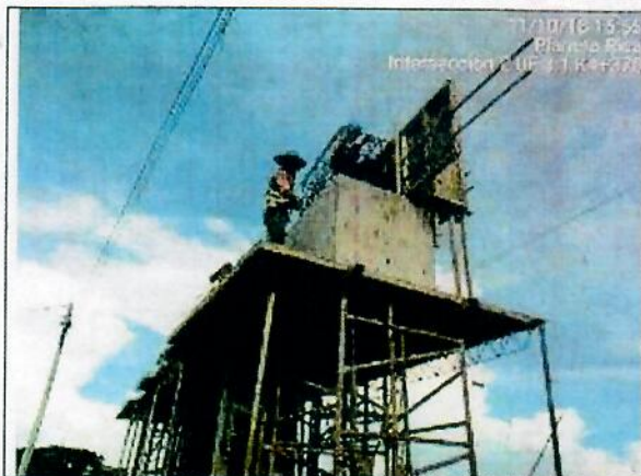
Foto 47. Encofrado de espaldar Eje 1
