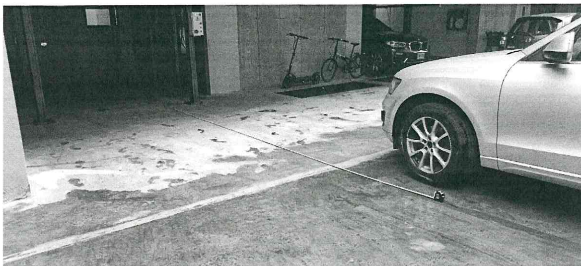
Fotografía 8 Circulación efectiva frente al estacionamiento 48 a equipo duplicador de 4 columnas - 5.01m
