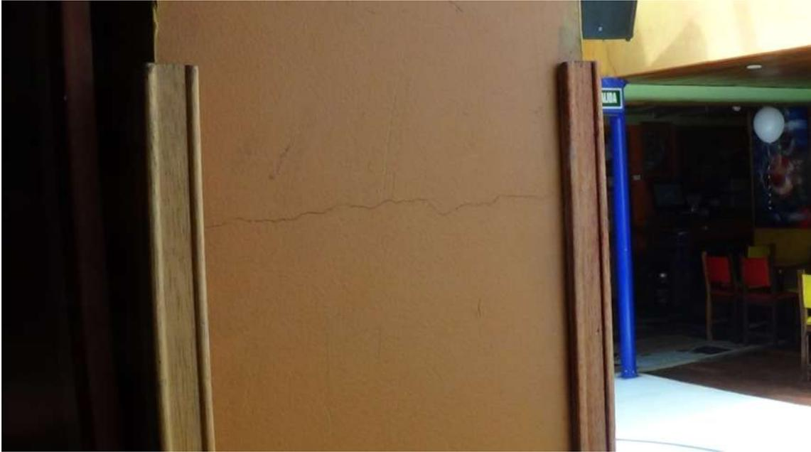
*Figura 4. Fisura Horizontal en muro portante del Salón 2 central. Foto No. 52 del Acta No. 95 del 30 de enero de 2015*
