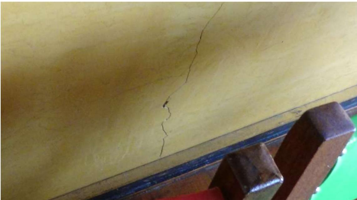
*Figura 5. Fisura escalonada en muro portante. Foto No. 66 del Acta No. 95 del 30 de enero de 2015*
