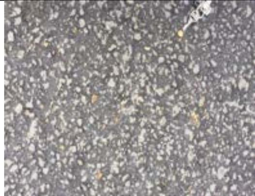
Foto 2. Presencia de agregado a nivel de la rodadura asfáltica, pérdida de agregado y deterioro de la capa asfáltica. (Cra 7d costado norte).
