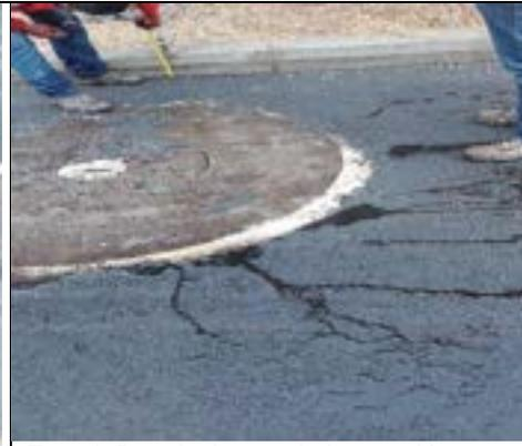
Foto 4. Desnivel pozo de inspección
