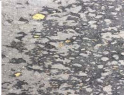
Foto 1. Presencia de agregado a superficie a nivel de la rodadura asfáltica, se evidencia un envejecimiento prematuro de la mezcla (Cra 7d costado norte).
