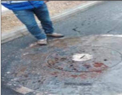
Foto 3. Desnivel pozo de inspección
