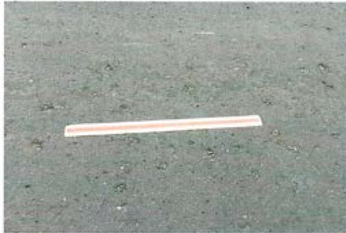
Fotografía 6. Desprendimiento de agregado
