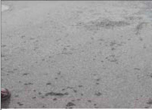
Foto 3. Se evidencia pérdida de agregado pétreo, se observa una baja adherencia entre el cemento asfáltico y el agregado (Cra 7d costado sur).
