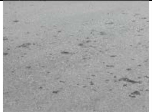
Foto 4. Se evidencia pérdida de agregado pétreo, se observa una baja adherencia entre el cemento asfáltico y el agregado. (Cra 7d costado sur).
