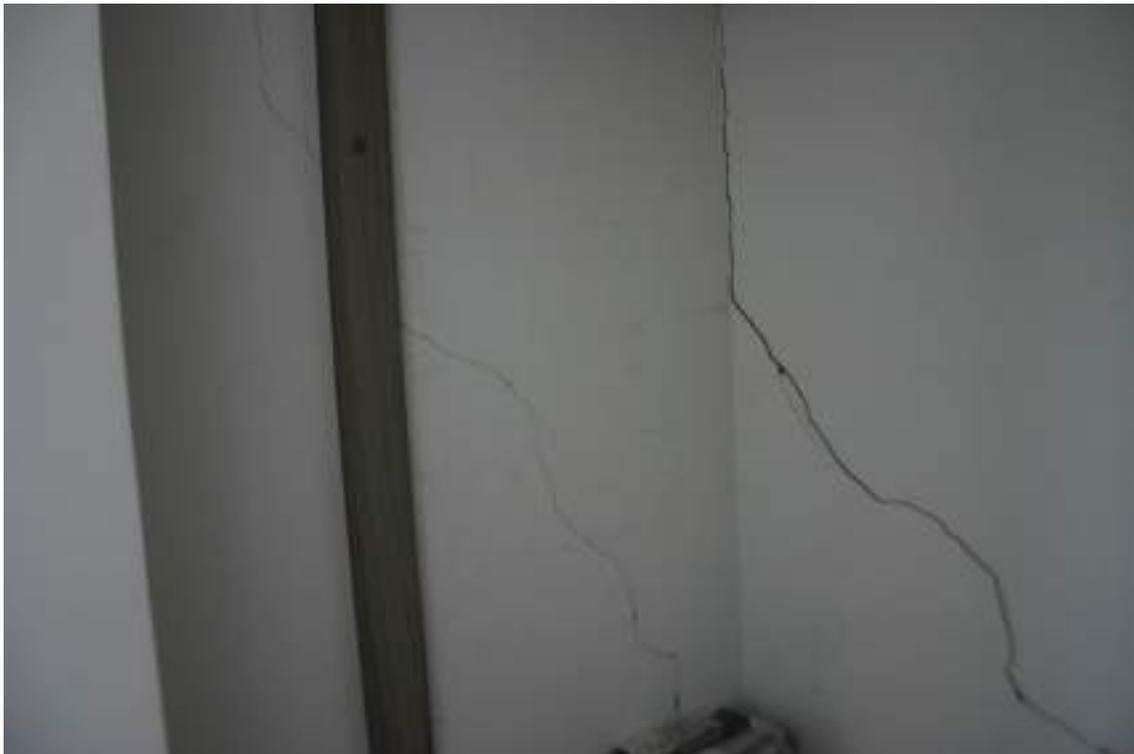
Figura 20 – Fisura en muros closet, segundo piso, Septiembre 2022
