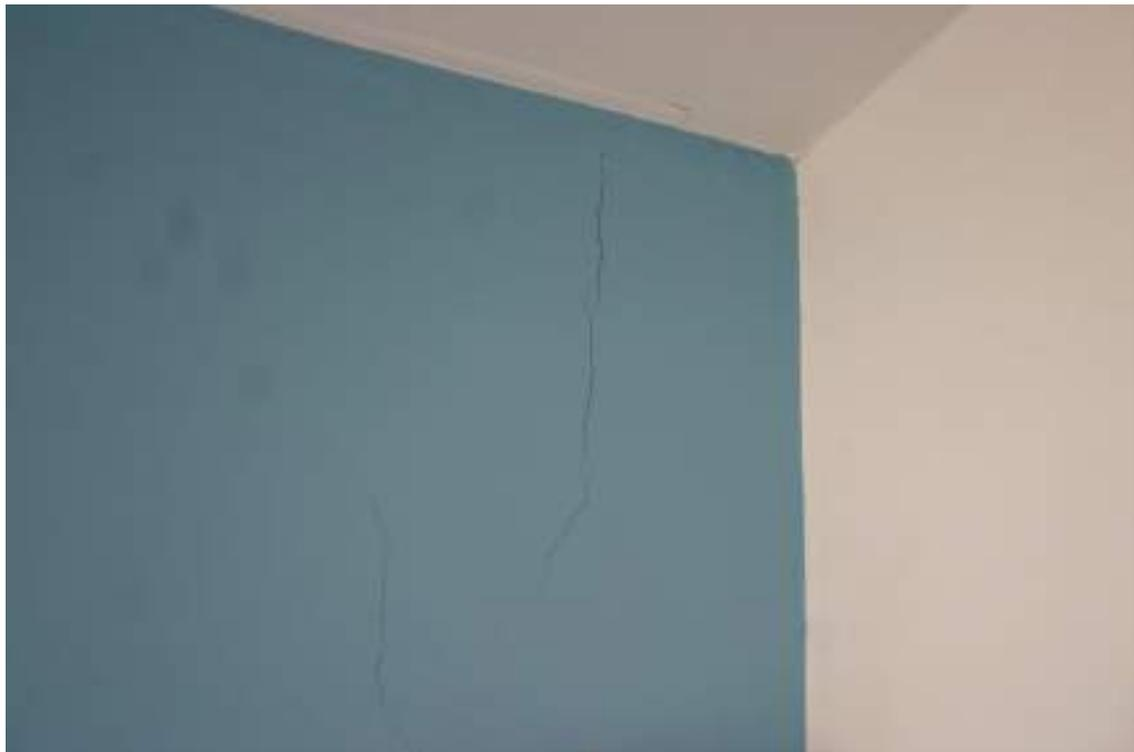
Figura 46 – Fisura muro alcoba tercer piso, Septiembre 2022
