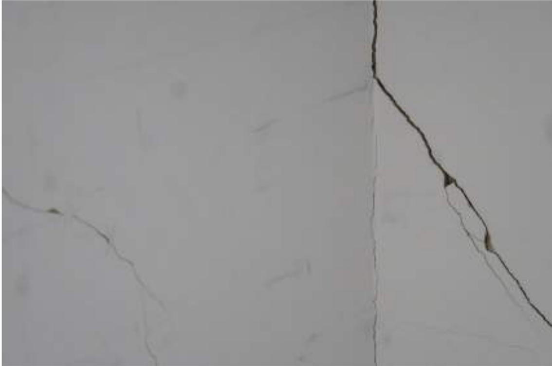
Figura 19 – Fisura en muros closet, segundo piso, Septiembre 2020
