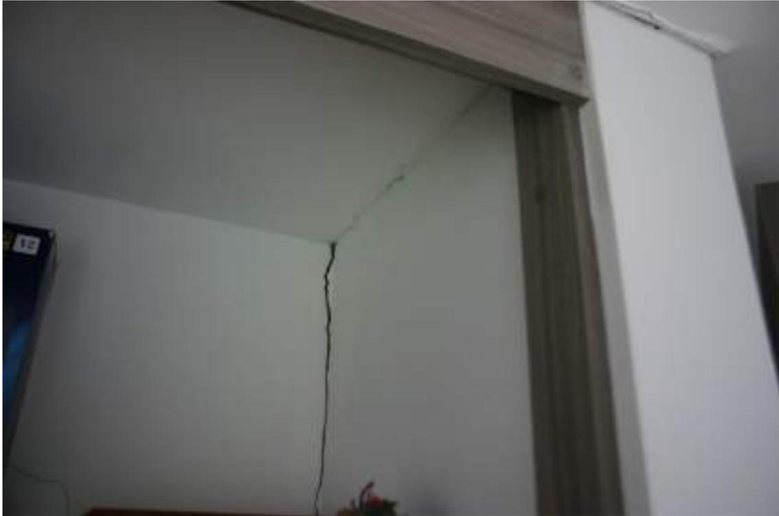
Figura 13 – Fisura en muros closet, segundo piso, Septiembre 2020
