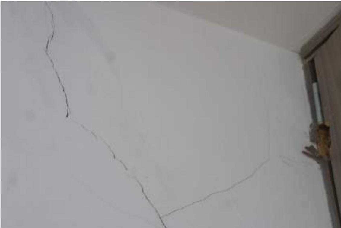
Figura 24 – Fractura muro, segundo piso, Septiembre 2022
