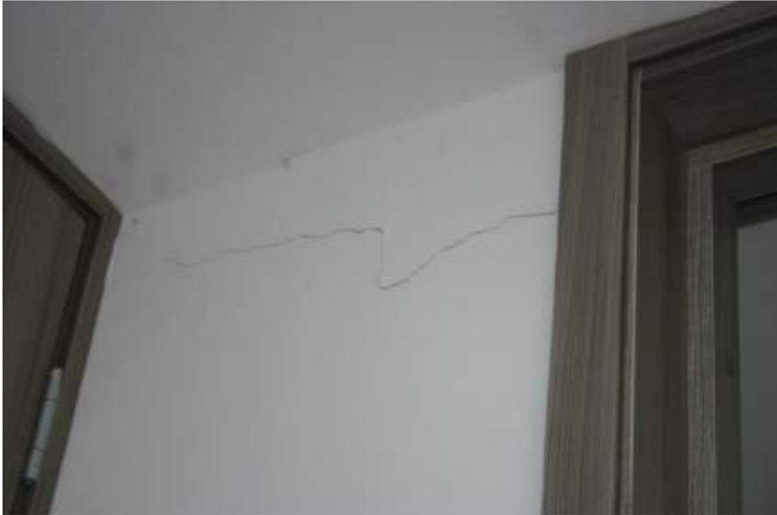
Figura 31 – Fisuras en muro alcoba segundo piso, Septiembre 2020
