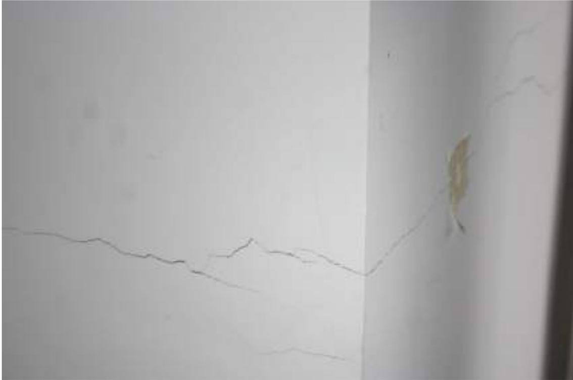
Figura 29 – Fisuras en muro segundo piso, Septiembre 2020
