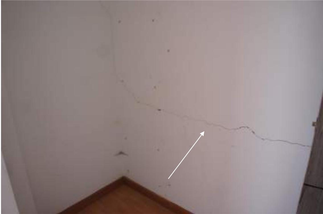
Figura 59 – Fisuras muros alcoba tercer piso, Septiembre 2022
