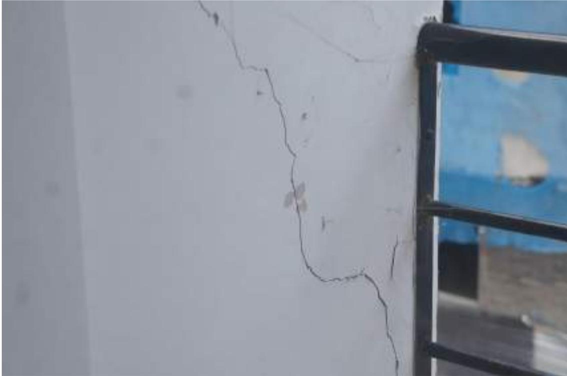
Figura 49 – Fisura muro balcón segundo piso, Septiembre 2020
