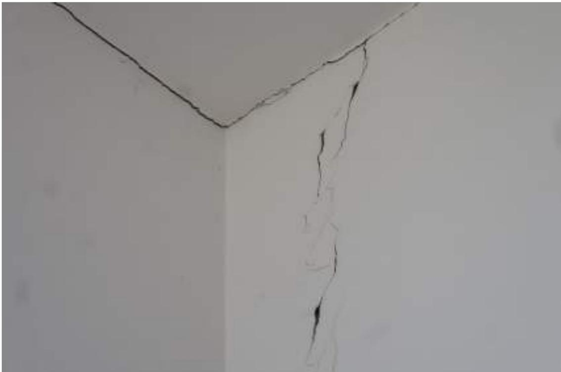
Figura 64 – Fisuras muros alcoba tercer piso, Septiembre 2022
