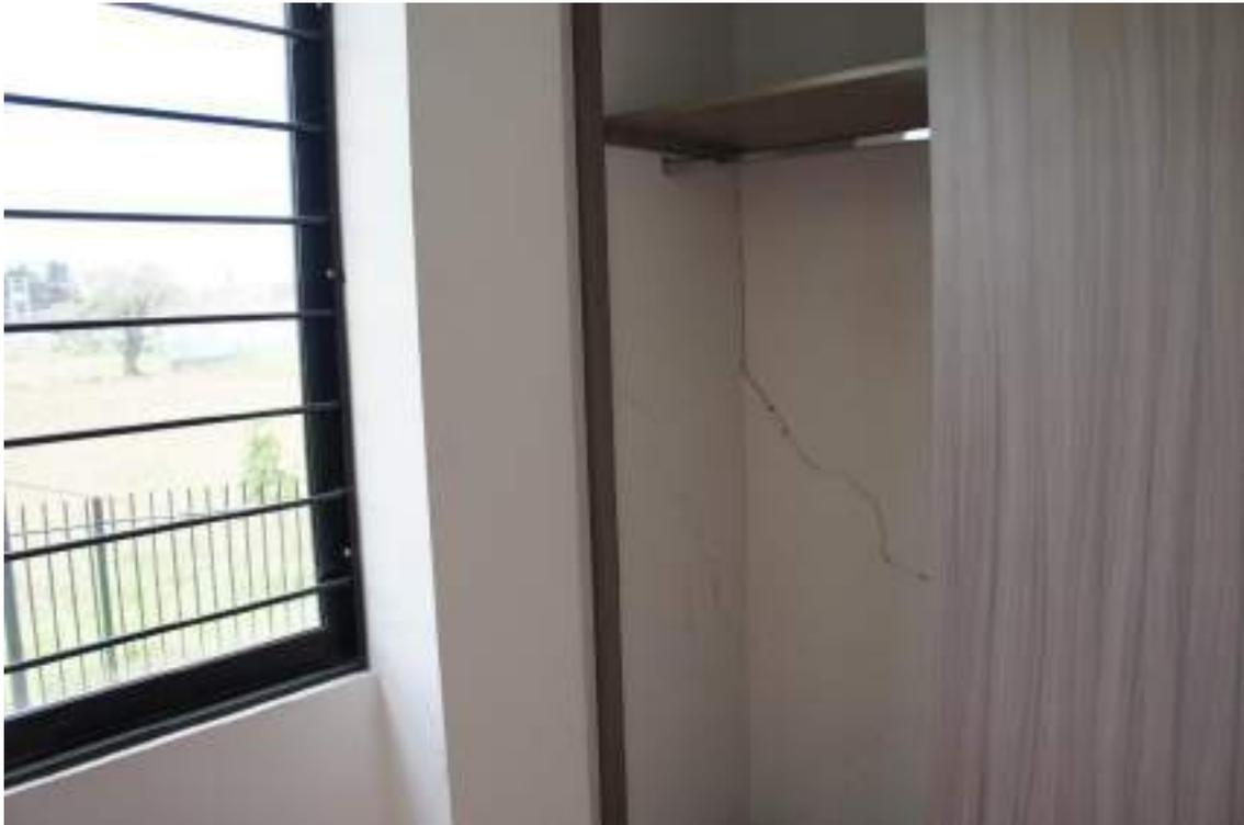
Figura 17 – Fisura en muros closet, segundo piso, Septiembre 2020
