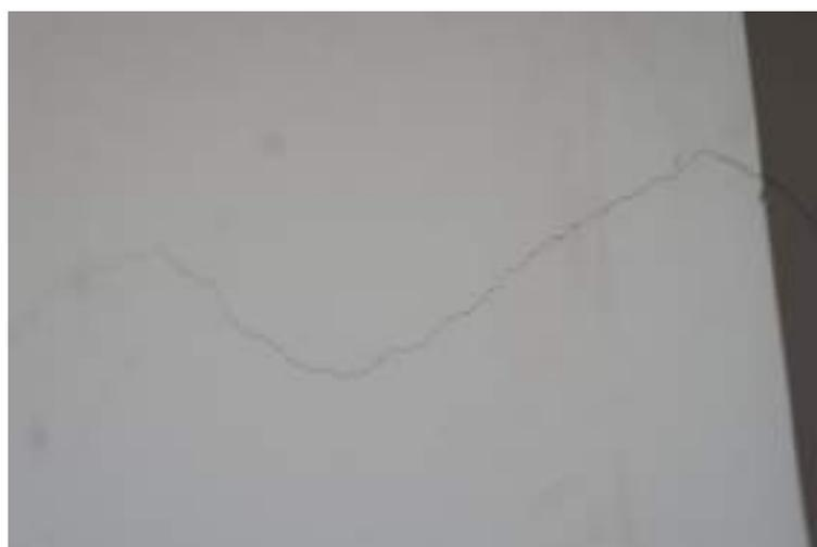
Figura 66 – Fisuras en muros del interior de la casa.
