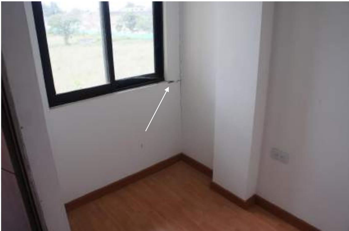
Figura 62 – Fisuras muros alcoba tercer piso, Septiembre 2022
