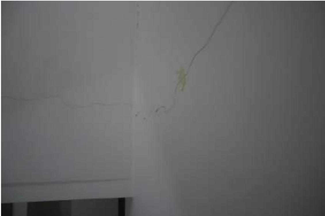
Figura 33 – Fisuras muros punto fijo escalera, Septiembre 2020
