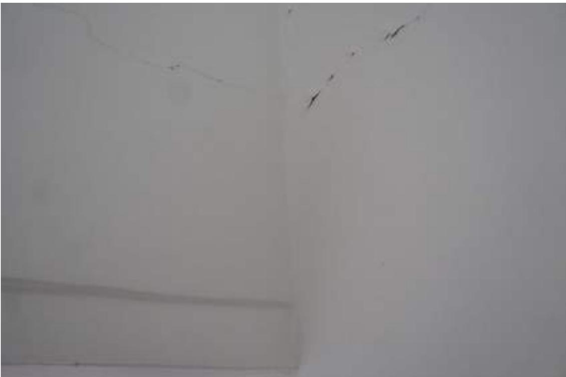
Figura 34 – Fisuras muros punto fijo escalera, Septiembre 2022
