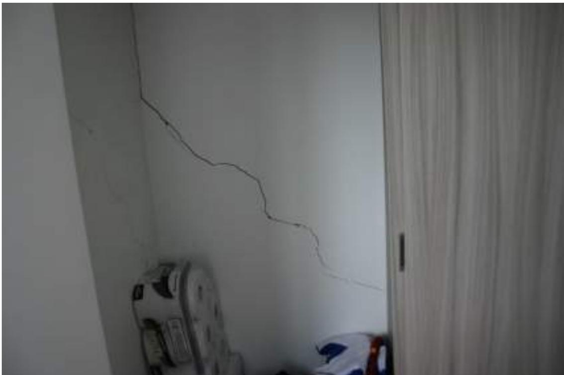
Figura 18 – Fisura en muros closet, segundo piso, Septiembre 2022
