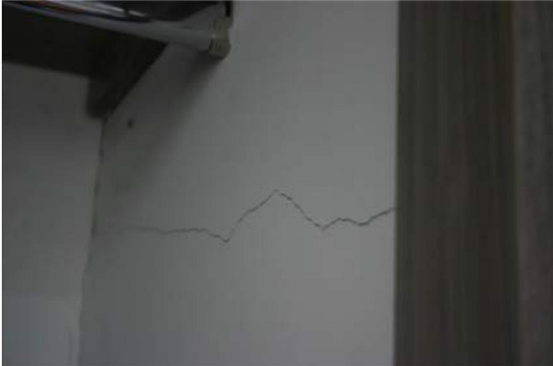
Figura 15 – Fisura en muros closet, segundo piso, Septiembre 2020
