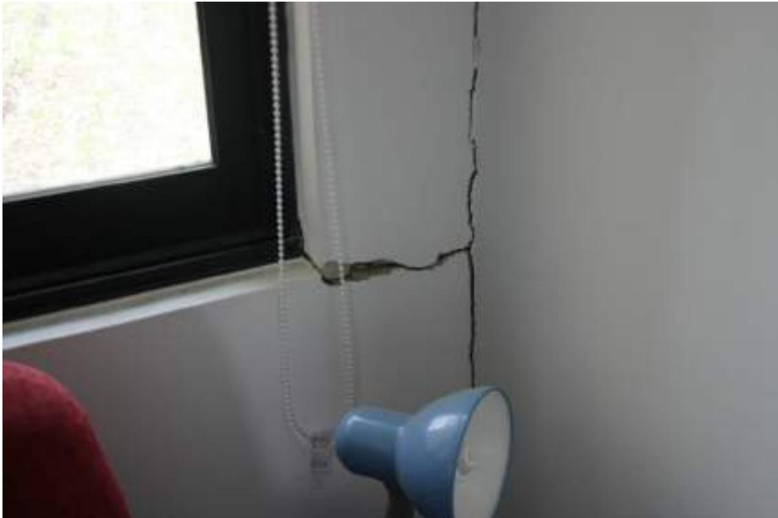
Figura 35 – Fractura muro ventana alcoba tercer piso, Septiembre 2020
