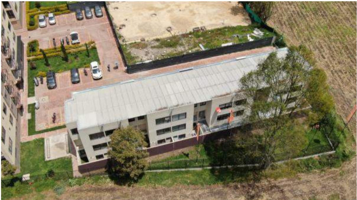
Figura 6 - Fachada posterior de las viviendas. La cubierta es a una sola agua.
