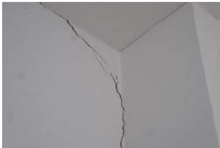
Figura 67 – Fisuras en muros del interior de la casa.
