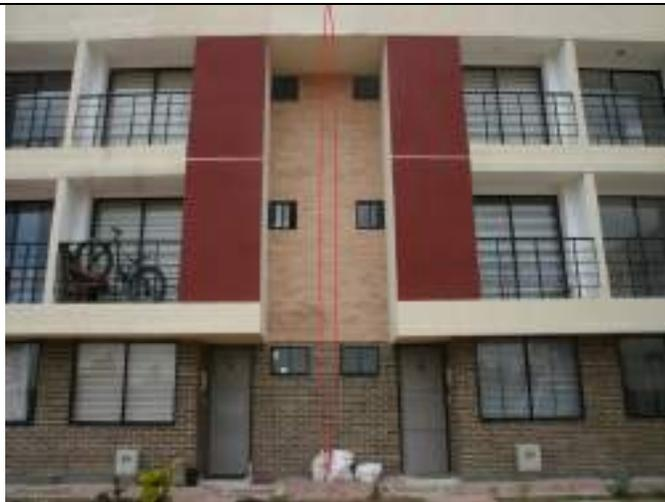
En lo construido, como se ve en la imagen, no se evidencia ninguna previsión de haber hecho la junta de construcción entre las casas 4 y 5.
