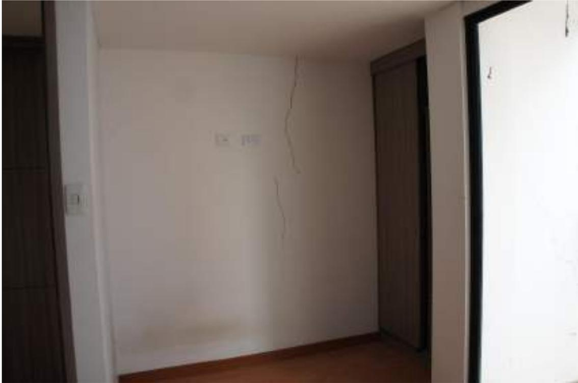
Figura 47 – Fisura muro alcoba tercer piso, Septiembre 2020
