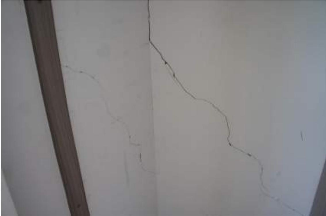
Figura 21 – Fisura en muros closet, segundo piso, Septiembre 2020
