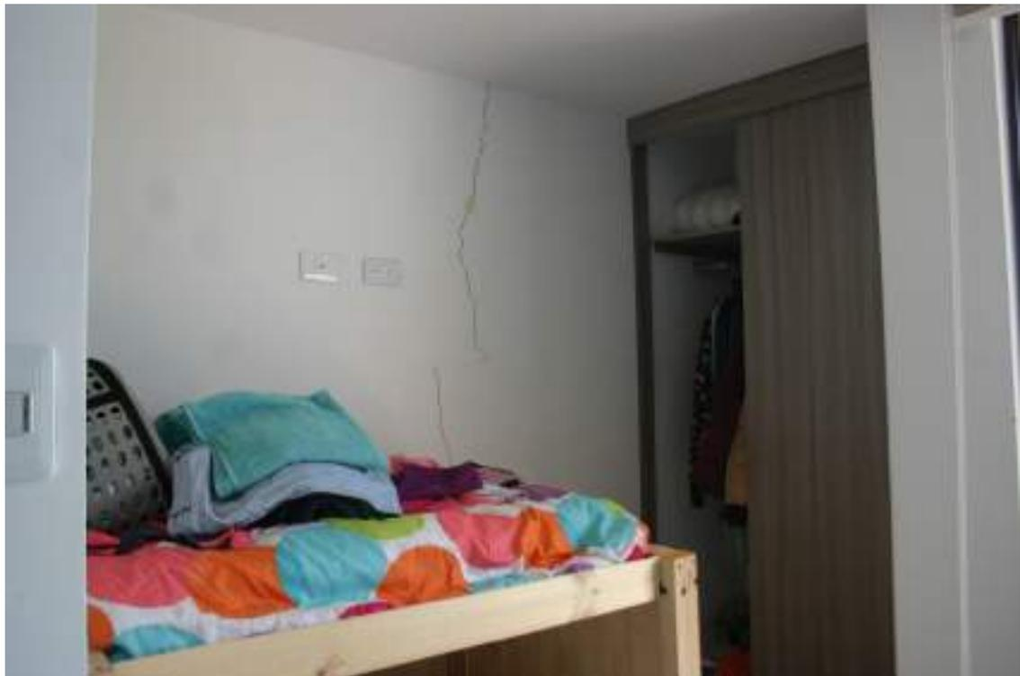
Figura 48 – Fisura muro alcoba tercer piso, Septiembre 2022
