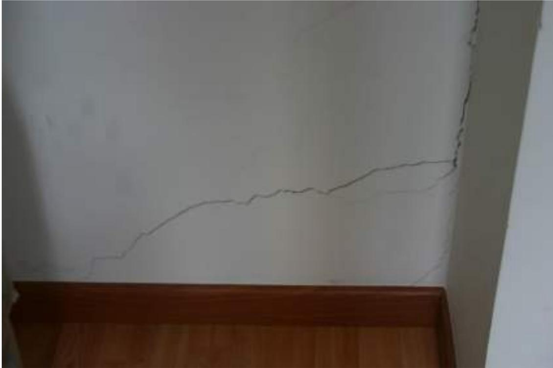
Figura 39 – Fisura muro alcoba tercer piso, Septiembre 2020
