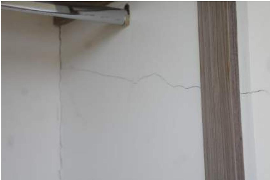
Figura 16 – Fisura en muros closet, segundo piso, Septiembre 2022
