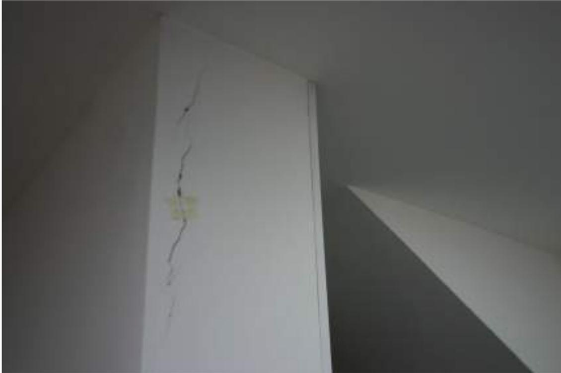
Figura 43 – Fisura muro hall primer piso, Septiembre 2020
