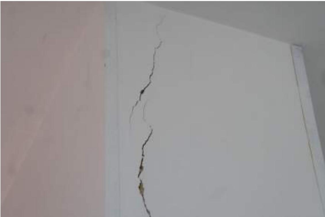
Figura 44 – Fisura muro hall primer piso, Septiembre 2022
