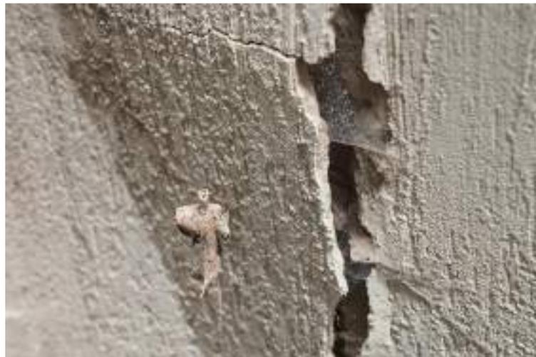
Figura 71 – Fisuras en muros del interior de la casa.
