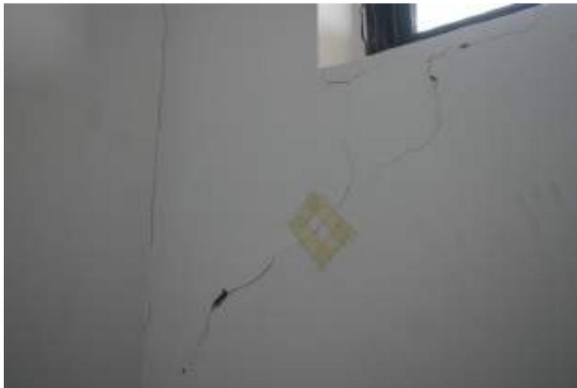
Figura 20 - Procedimiento instalación marcas de yeso.
