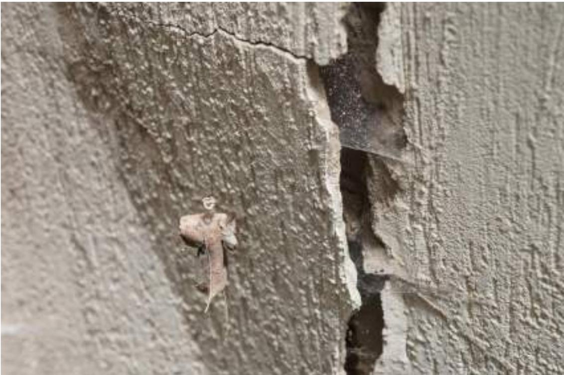
Figura 10 – Detalle afectación muro cerramiento patio posterior, Septiembre 2022
