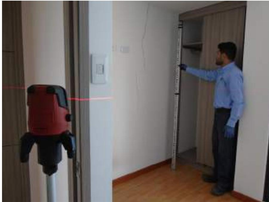
Figura 28 – Proceso de nivelación de placas.
