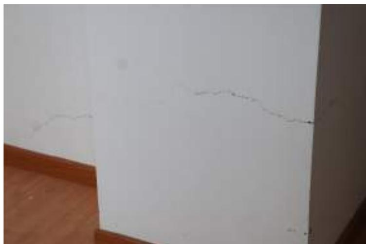
Figura 65 – Fisuras en muros del interior de la casa.
