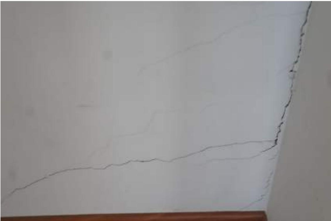
Figura 40 – Fisura muro alcoba tercer piso, Septiembre 2022
