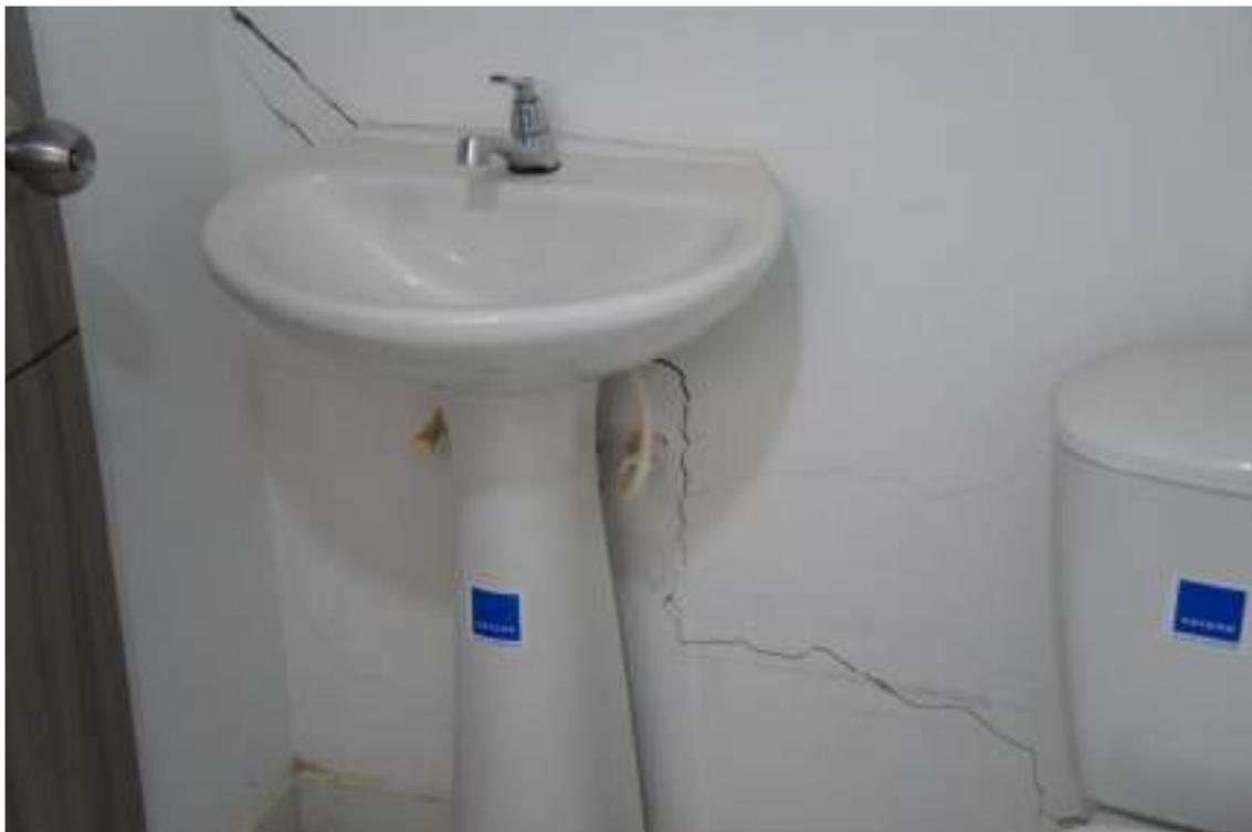
Figura 42 – Fractura muro baño tercer piso, Septiembre 2022
