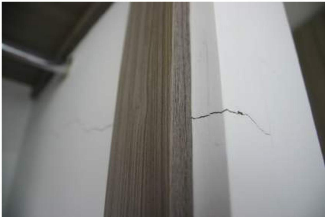
Figura 22 – Fisura en muros closet, segundo piso, Septiembre 2022
