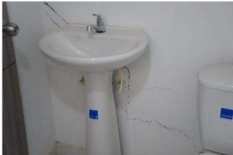
Figura 68 – Fisuras en muros del interior de la casa.
