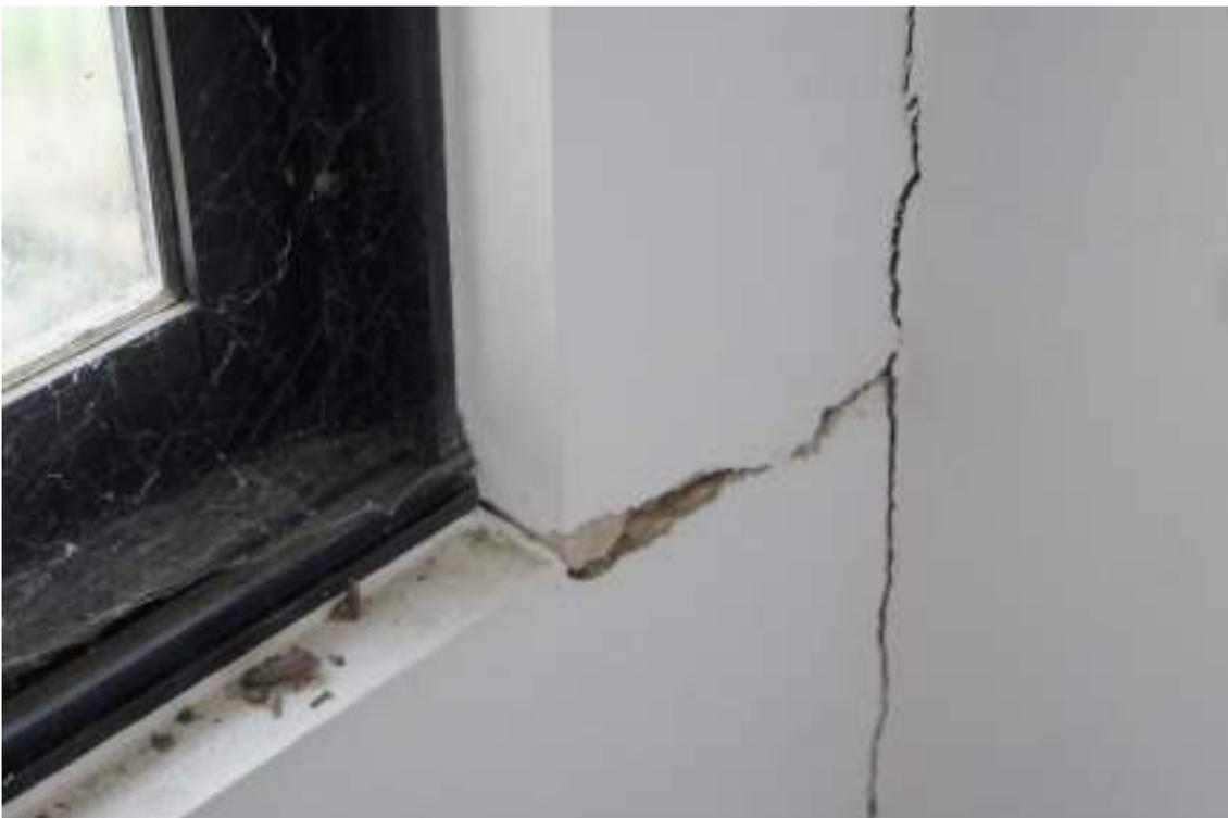
Figura 36 – Fractura muro ventana alcoba tercer piso, Septiembre 2022
