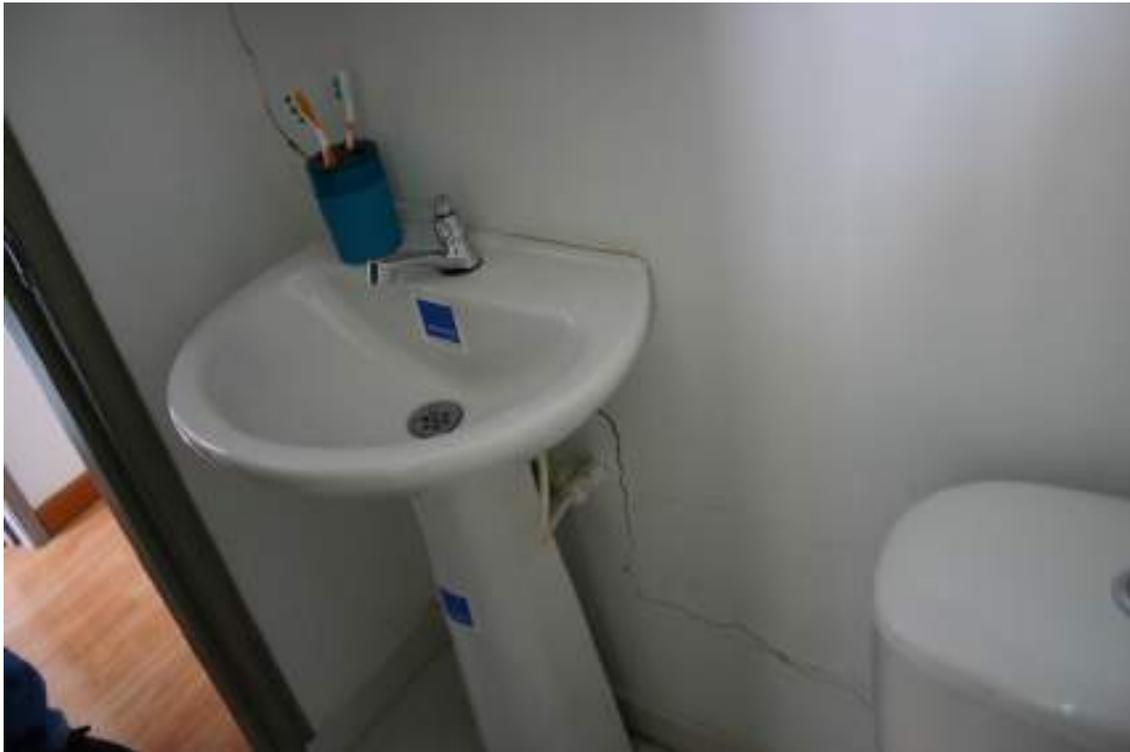
Figura 41 – Fractura muro baño tercer piso, Septiembre 2020
