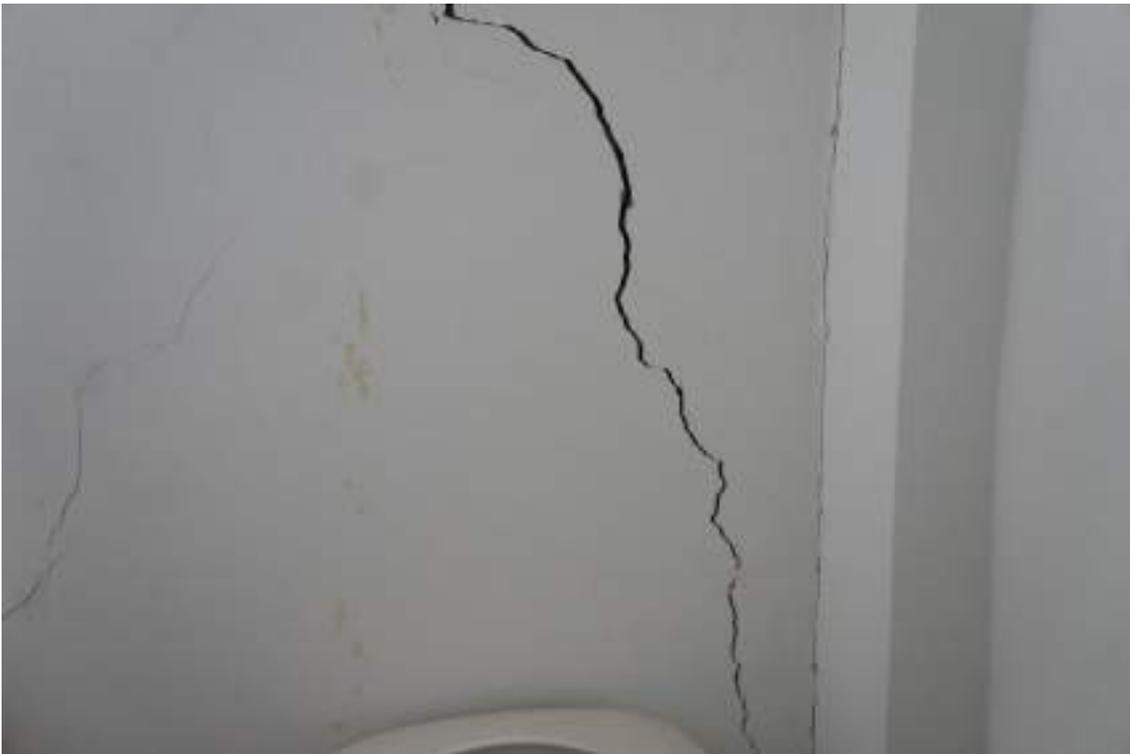
Figura 26 – Fractura muro en baño, segundo piso, Septiembre 2020
