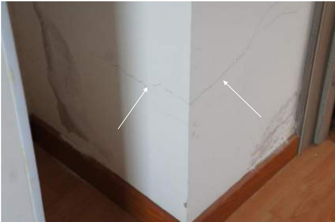
Figura 70 – Fisuras muros, tercer piso, Septiembre 2022
