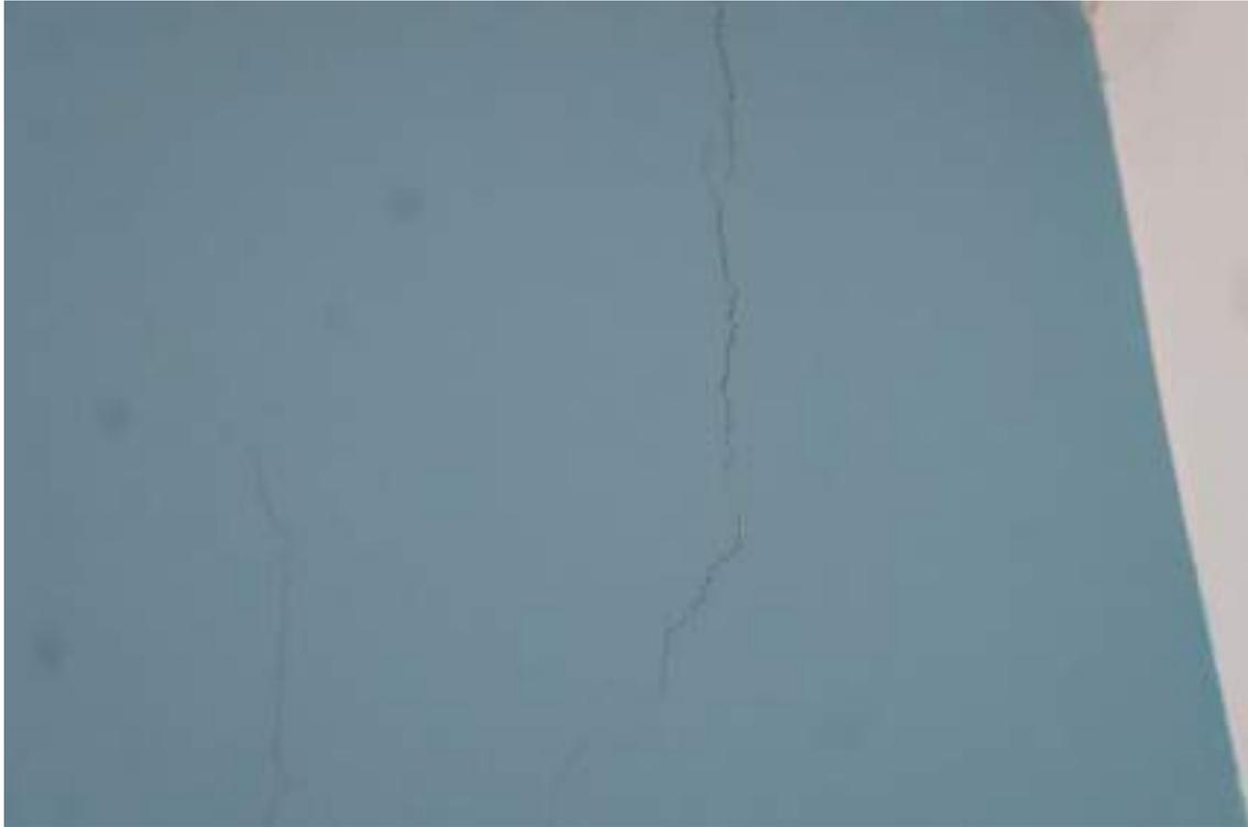
Figura 45 – Fisura muro alcoba tercer piso, Septiembre 2020
