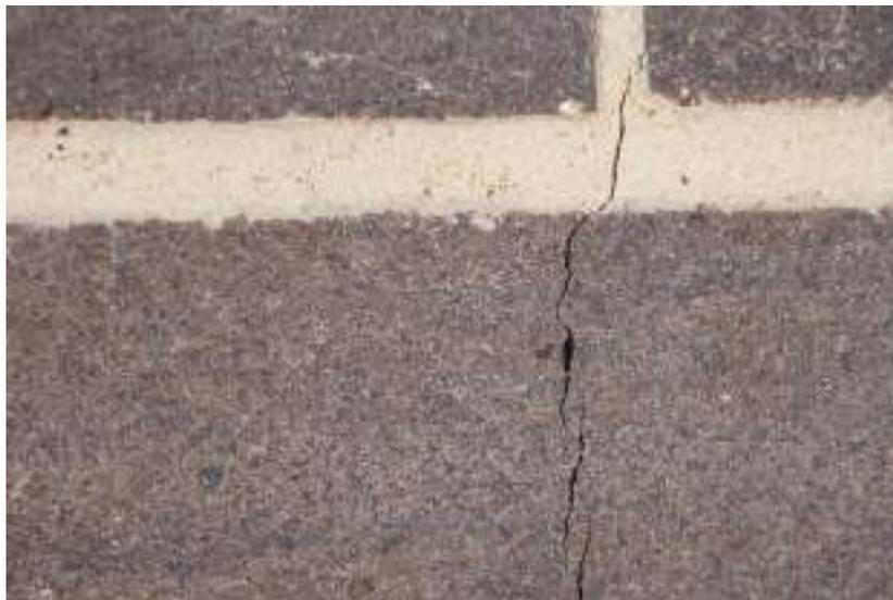
Figura 64 – Fisuras enmuros de fachada principal
