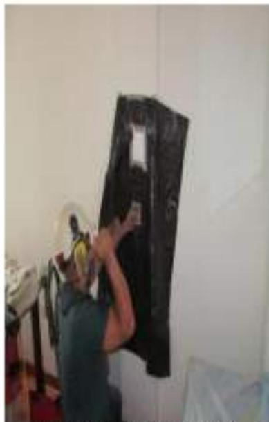
Figura 163 - Procedimiento de extracción de núcleos.
