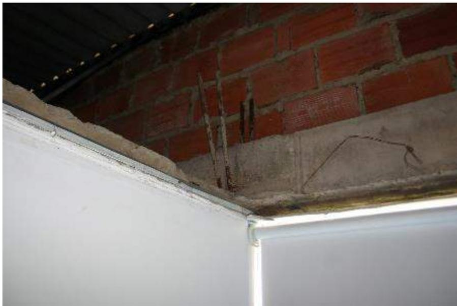
Figura 16 – Falta de continuidad de las columetas para las culatas
