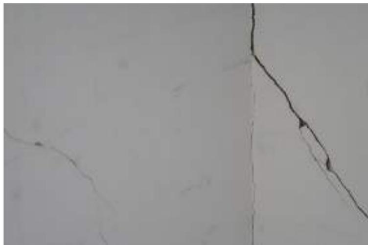
Figura 69 – Fisuras en muros del interior de la casa.
