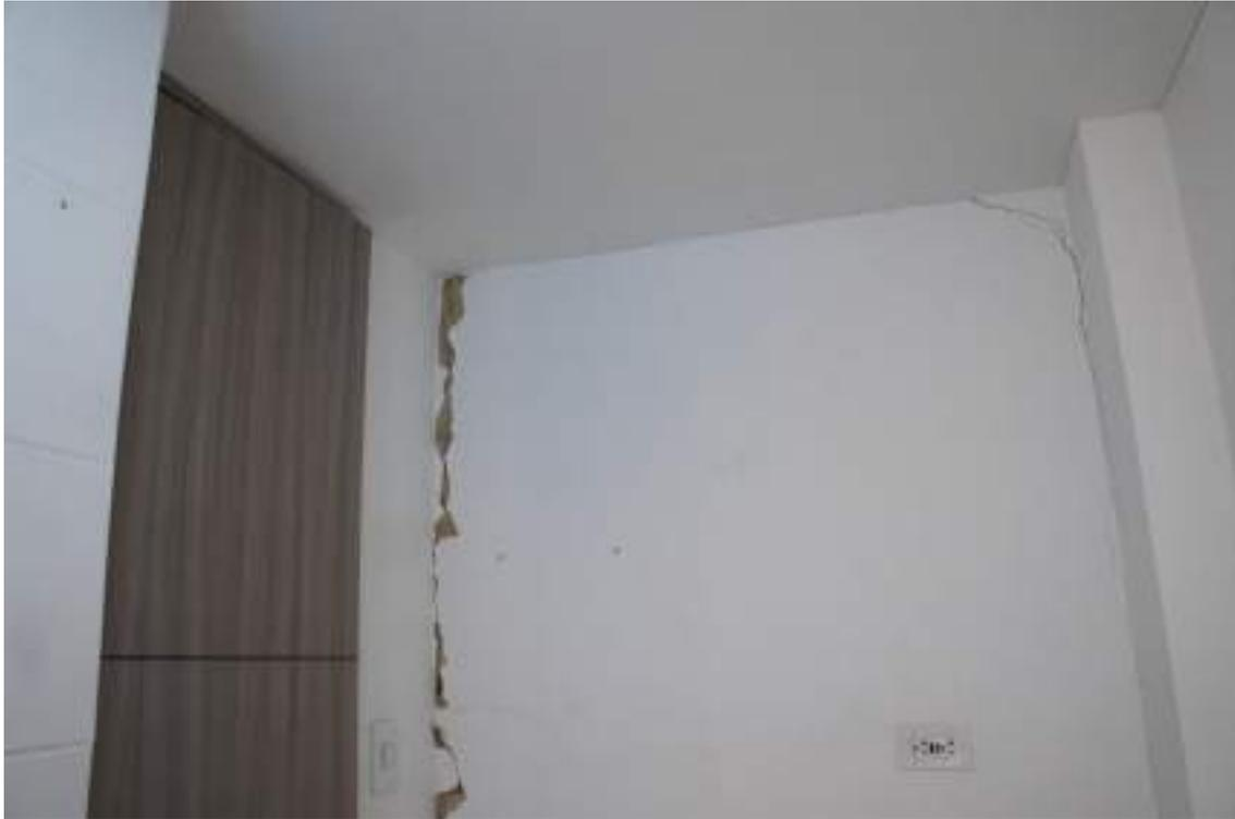
Figura 65 – Fisuras muros alcoba tercer piso, Septiembre 2022
