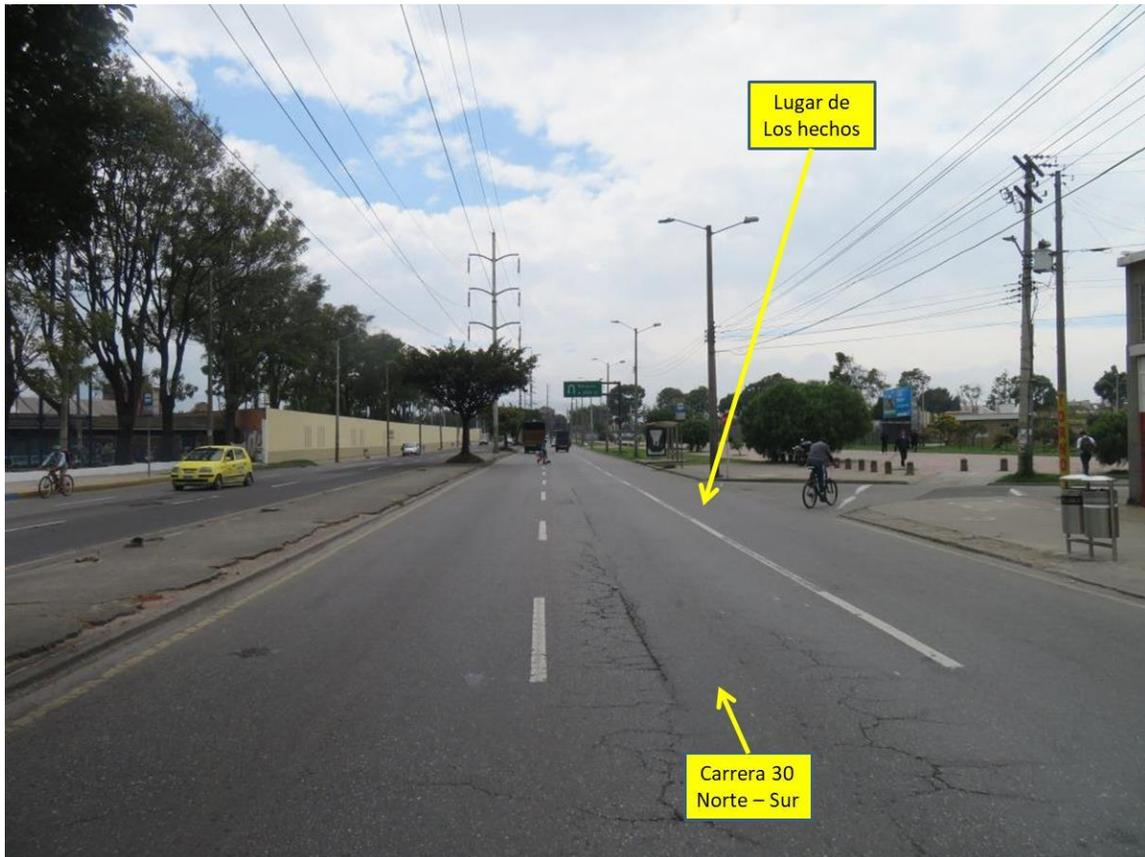
**FOTOGRAFÍA No. 3 PANORÁMICA:** En esta fotografía tomada por el equipo de IRS Vial en sentido norte – sur en la carrera 30 a la altura de la calle 32 sur, se aprecian las características generales de la vía en la cual se encuentra demarcación horizontal de línea blanca segmentada y líneas de borde, sin señalización vertical; en este sentido se desplazaban los vehículos.
