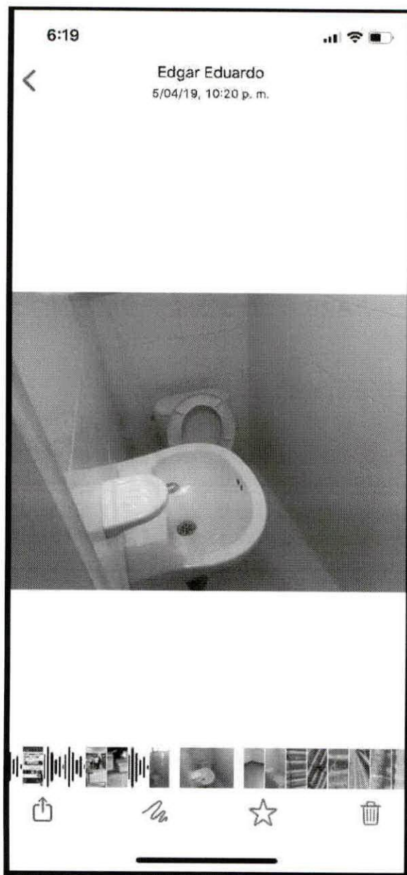
Foto 05/04/2019 Baño 1er piso arreglado
