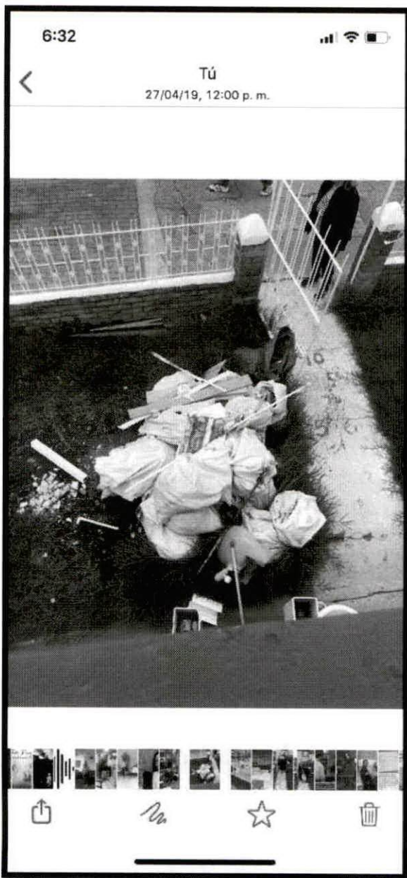
Foto 27/04/2019 Retiro de Escombros Finalización de obra arreglos.
