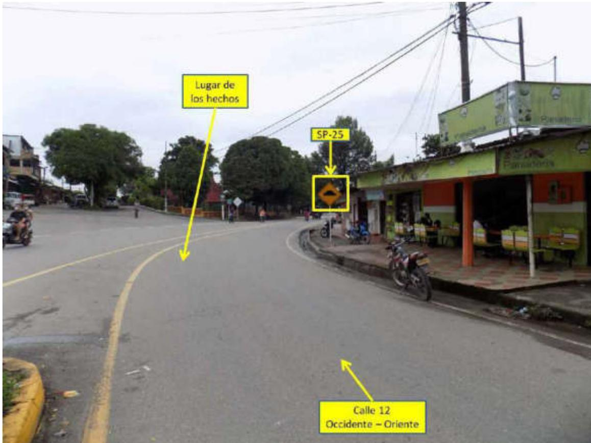
**FOTOGRAFÍA No. 3 PANORÁMICA:** En esta fotografía tomada por el equipo de IRS Vial en sentido occidente – oriente en la calle 12 con carrera 17, se aprecian las características generales de la vía en la cual se encuentra demarcación horizontal de líneas de borde, con señalización vertical SP-25 “Resalto”; en este sentido se desplazaban los vehículos.
