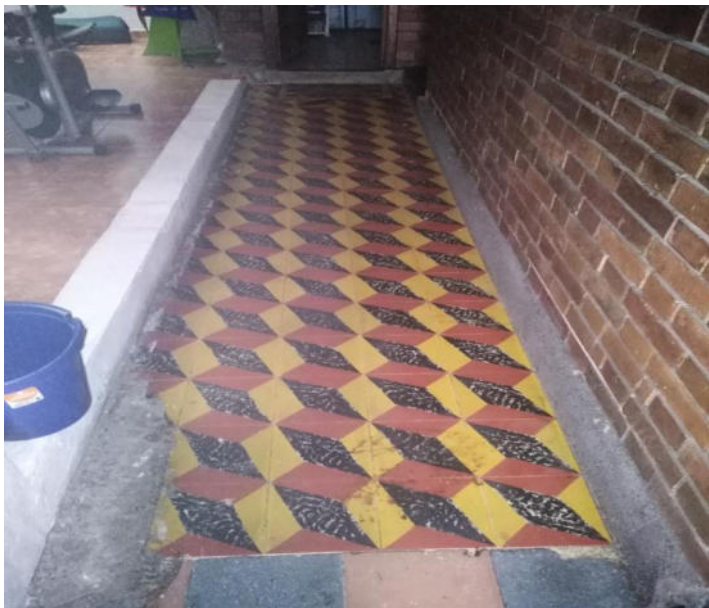
CORREDOR SEGUNDO PISO
