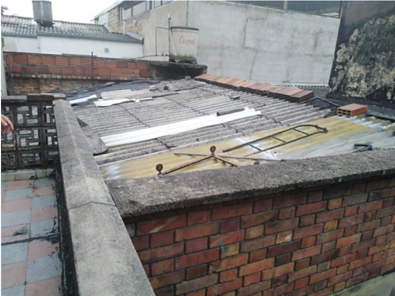
CONSTRUCCION AMPLIACION EN EL FONDO DEL INMUEBLE
