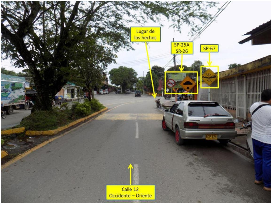
**FOTOGRAFÍA No. 2 PANORÁMICA:** En esta fotografía tomada por el equipo de IRS Vial en sentido occidente – oriente en la calle 12 entre carreras 18 y 17, se aprecian las características generales de la vía en la cual se encuentra demarcación horizontal de línea blanca segmentada y líneas de borde, con señalización vertical SP-67 “Riesgo de accidente”, SP-25A “Resalto” y SR-26 “Prohibido adelantar”, con resalto en la vía; en este sentido se desplazaban los vehículos.
