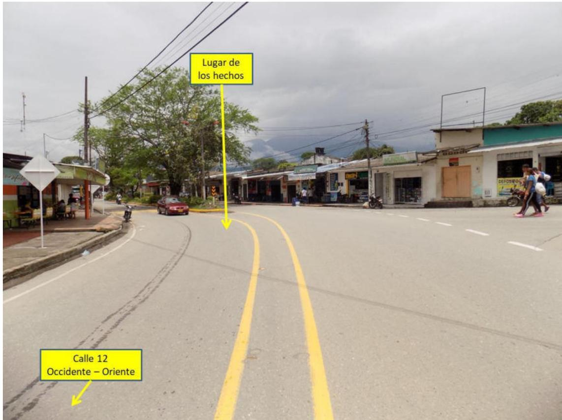
**FOTOGRAFÍA No. 4 PANORÁMICA:** En esta fotografía tomada por el equipo de IRS Vial en sentido oriente - occidente en la calle 12 con carrera 17, se aprecian las características generales de la vía en la cual se encuentra demarcación horizontal líneas de borde, sin señalización vertical.
