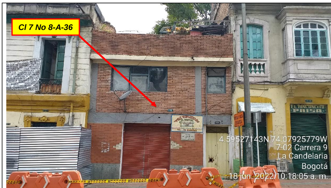
FACHADA DEL INMUEBLE (18-06-22)
