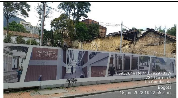
Fotografía 8. Manzana 4 (en demolición)
