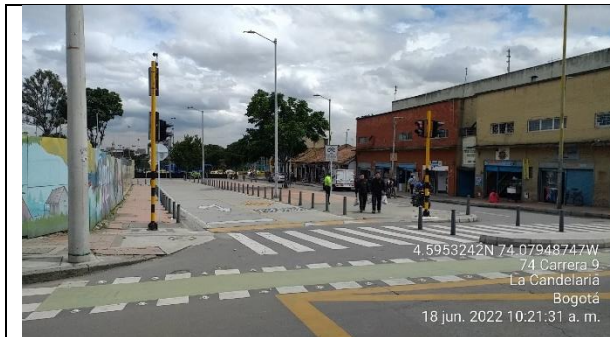
Fotografía 1. Calle 7 al occidente(18-06-22)
