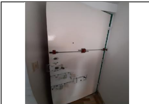
PUERTA DE ACCESO AL APARTAMENTO 202 VISTA INTERNA
