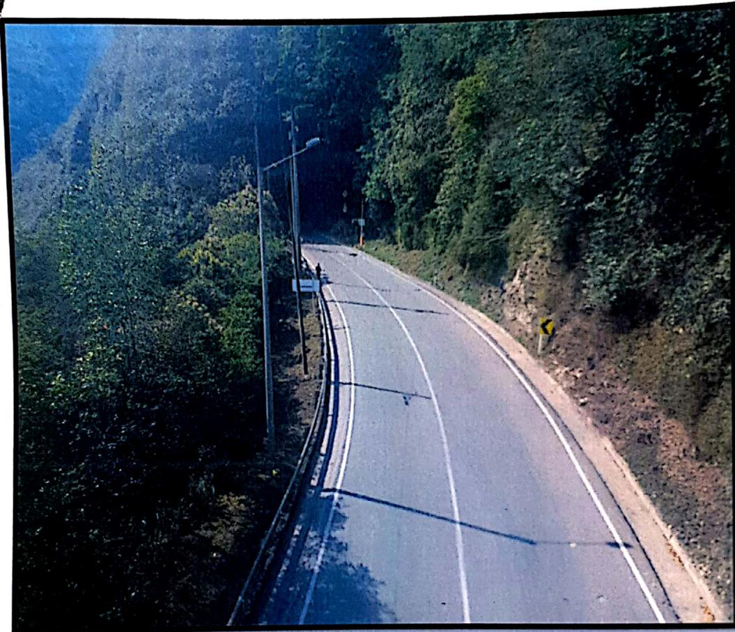
**FOTOGRAFIA N° 3. Plano Panorámico.** Vista aérea del kilómetro 55 + 400 metros de la vía Bogotá – Villavicencio, la cual corresponde a una vía de una calzada, con dos carriles, en descenso, material asfalto con curvas pronunciadas a la derecha y posteriormente a la izquierda. Adicionalmente se observa una señal preventiva SP-27 descenso peligroso. Sentido sur – norte.
