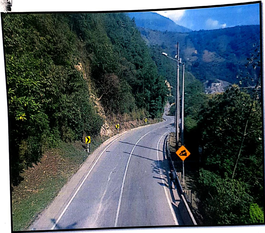
**FOTOGRAFIA N° 1. Plano Panorámico.** Vista aérea del kilómetro 55 + 400 metros de la vía Bogotá – Villavicencio, la cual corresponde a una vía de una calzada, con dos carriles, en descenso, material asfalto con curvas pronunciadas a la derecha y posteriormente a la izquierda. Adicionalmente se observa una señal preventiva SP-27 descenso peligroso.
