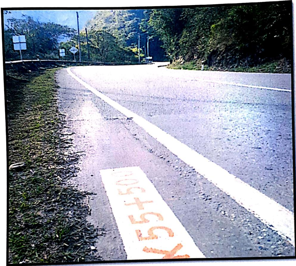
**FOTOGRAFIA N° 5. Plano general.** Vista aérea del kilómetro 55 + 400 metros de la vía Bogotá – Villavicencio, la cual corresponde a una vía de una calzada, con dos carriles, en descenso, material asfalto con curvas pronunciadas a la derecha y posteriormente a la izquierda. Adicionalmente se observa una señal preventiva SP-27 descenso peligroso. Sentido sur – norte.
