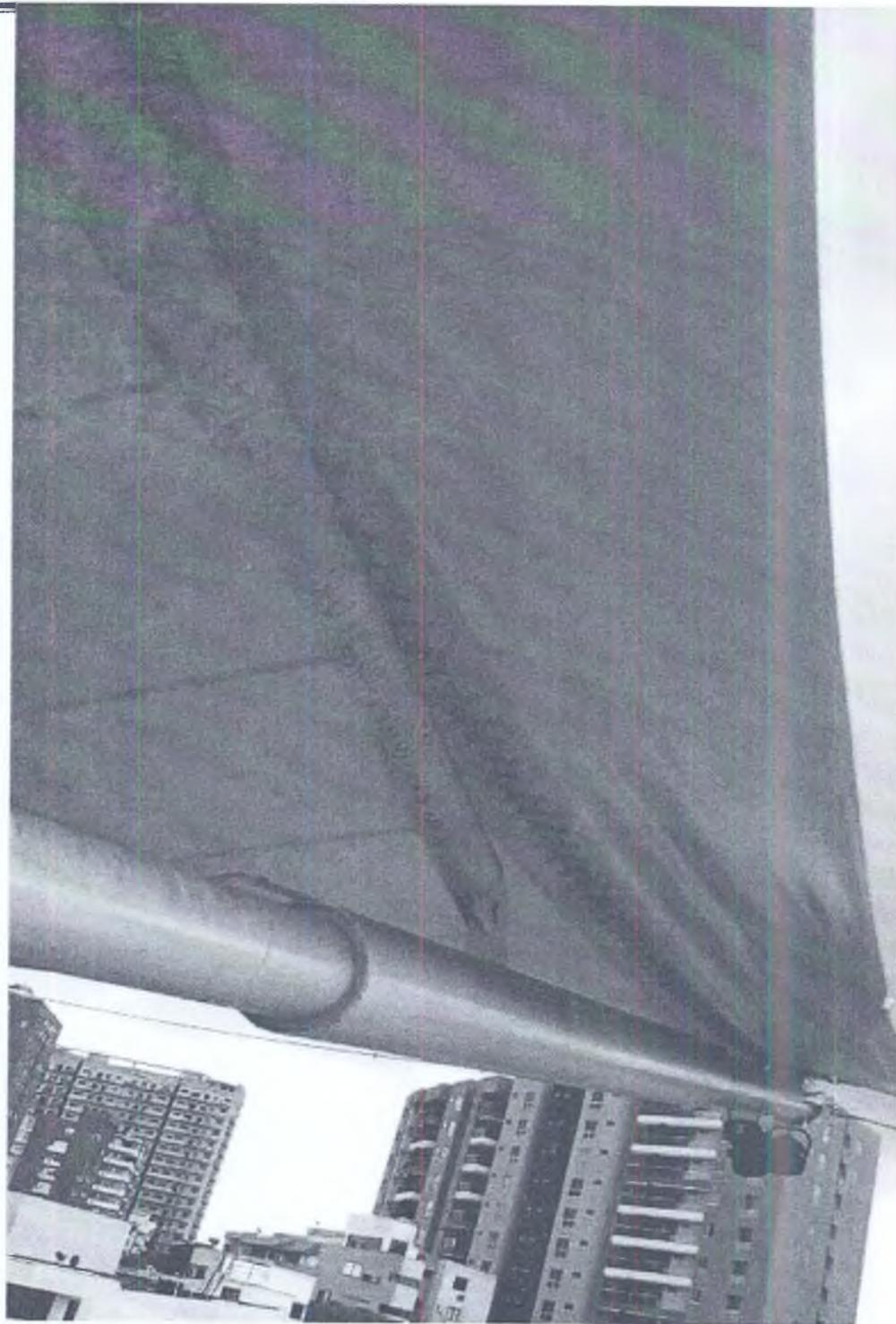
RASGADURAS EN LOS PUNTOS DE TENSION DEBIDO A LA MALA CALIDAD DE MATERIALES Y/O
