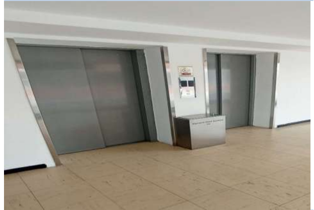
PUERTA ACCESO OFICINA
