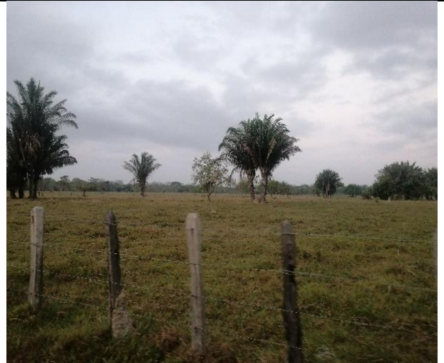
OTRA ÁREA AFECTADA POR LA LÍNEA
