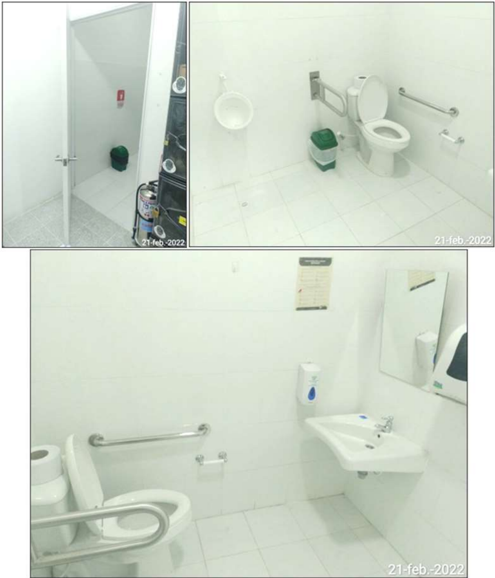
Registro fotográfico 2. Servicio sanitario el cual se encuentra habilitado para las personas con movilidad reducida.
