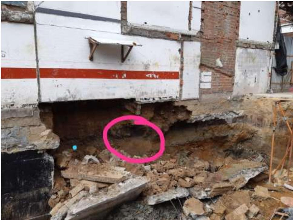
Adicionalmente, dado que en el predio vecino se realizaba lavado (alistamiento) de vehículos, se presentó una sobresaturación del suelo en forma errática y sin control, la cual no fue detectada hasta el colapso del tramo de recinte; dicha agua generó por ende un aumento significativo del peso de suelo y trajo como consecuencia la caída parcial de un tramo de contención la cual había sido realizada en forma técnica.
