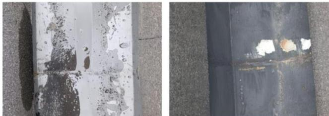
6. **Bajantes Cubierta:** Un bajante de aguas lluvias presenta un problema, el codo entre la canoa y la tubería fue recortado, con el fin que encajara a la canoa, generando una incorrecta conexión entre las dos piezas, impidiendo que el agua fluya con regularidad incluso en ocasiones que el agua se devuelve y se meta por debajo de la canoa, filtrando hasta el cielo de la cocina y presentando humedades interiores.
