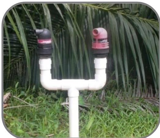
Válvulas de Aire Doble Efecto, Permite las dos principales funciones de las válvulas de aire, expulsión en el llenado de la tubería y admisión en el vaciado.
