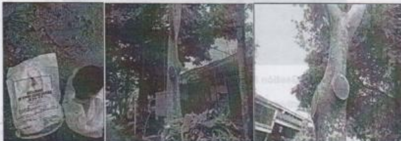
Fotografía 3. Labores de cicatrización.
