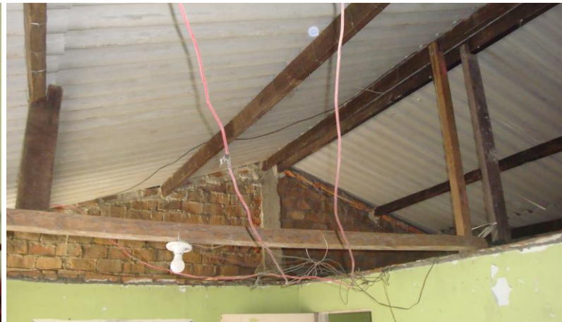
CUBIERTA EN ESTADO DE REPARACIÓN – INSTALACIONES A LA VISTA
