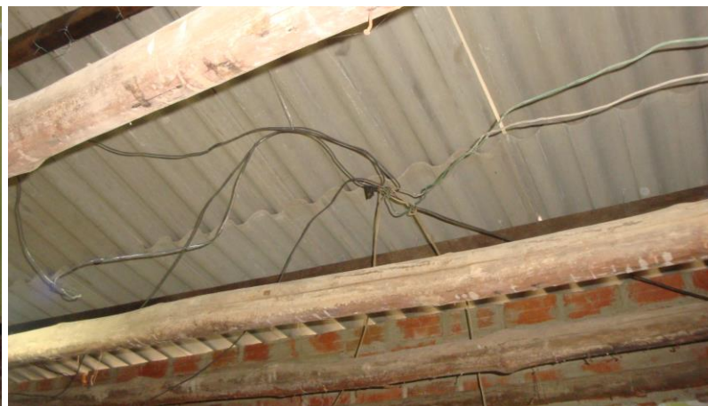
EN PROCESO LA REPARACIÓN DE LA CUBIERTA
