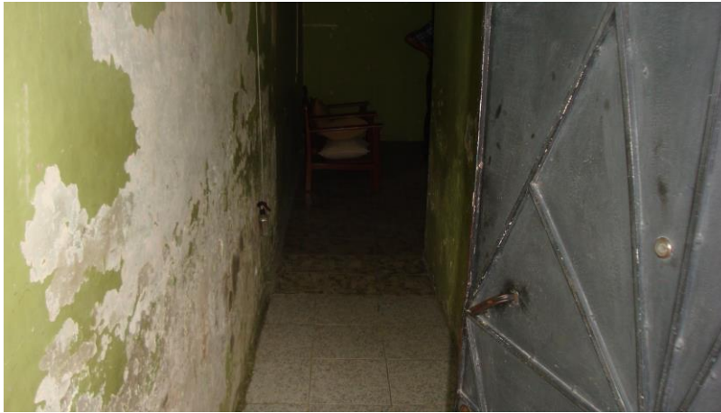
PUERTA METÁLICA DE ACCESO A ZAGUAN O CIRCULACIÓN
