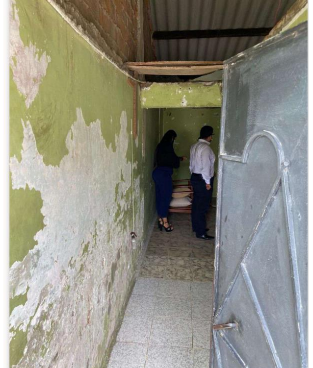
PUERTA METÁLICA DE ACCESO A CIRCULACIÓN
