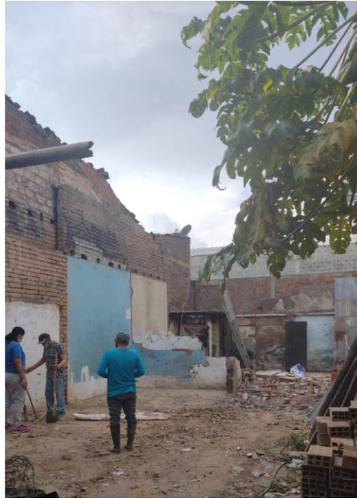
**Imagen número 20.** Colocada parte de los materiales producto de la demolición sobre el andén de la entrada principal del inmueble para su retiro en volqueta
