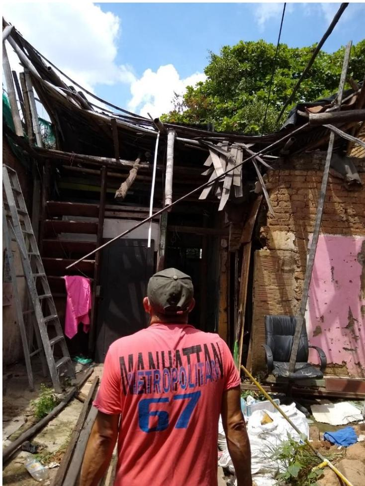
**Imagen número 2.** Foto del inmueble tomada en sentido norte-sur, en donde podemos detallar las condiciones de inseguridad estructural. Guaduas sueltas, entramados sin ninguna seguridad para sus habitantes
