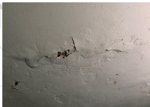
HUMEDADES MUROS SEGUNDO NIVEL
