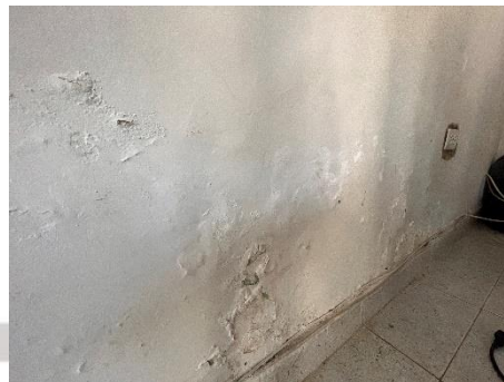
HUMEDADES DE LOS MUROS PARTE INFERIOR 1 NIVEL
