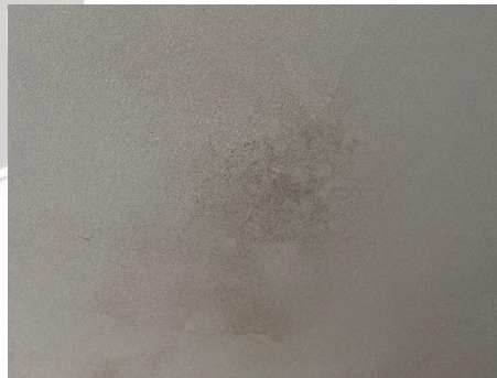
HUMEDADES CIELO FALSO DE LA PLACA
