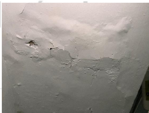
HUMEDADES MUROS SEGUNDO NIVEL
