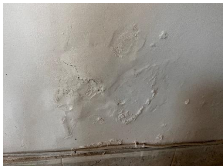
HUMEDADES DE LOS MUROS PARTE INFERIOR 1 NIVEL
