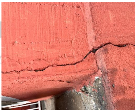
GRIETA FACHADA Y PLACA FUTURA AREA DE AMPLIACION 2 NIVEL
