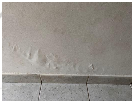
HUMEDADES EN LA PARTE SUPERIOR E INFERIOR
