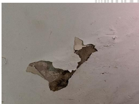
HUMEDADES MUROS SEGUNDO NIVEL
