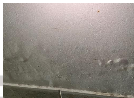
HUMEDADES EN LA PARTE INFERIOR DE LOS MUROS
