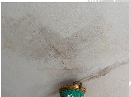
HUMEDADES CIELO FALSO DE LA PLACA
