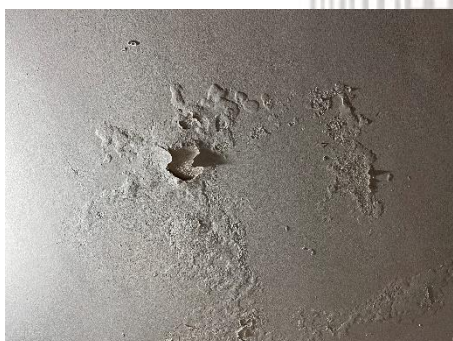
HUMEDADES EN LA PARTE INFERIOR DE LOS MUROS
