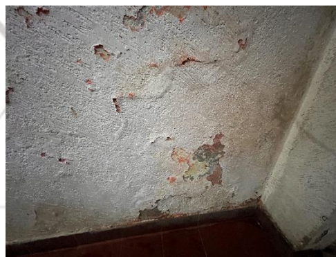
HUMEDADES PLACA Y MUROS
