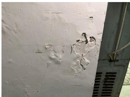
HUMEDADES EN LA PARTE INFERIOR DE LOS MUROS
