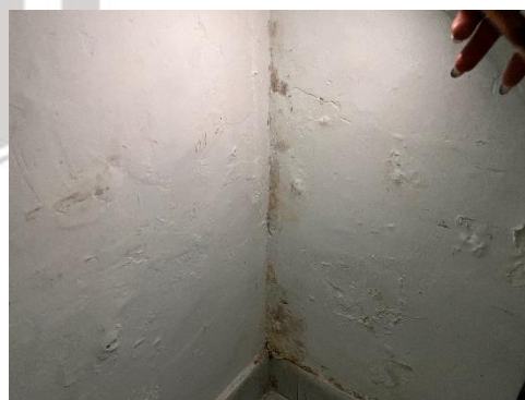
HUMEDADES MUROS SEGUNDO NIVEL
