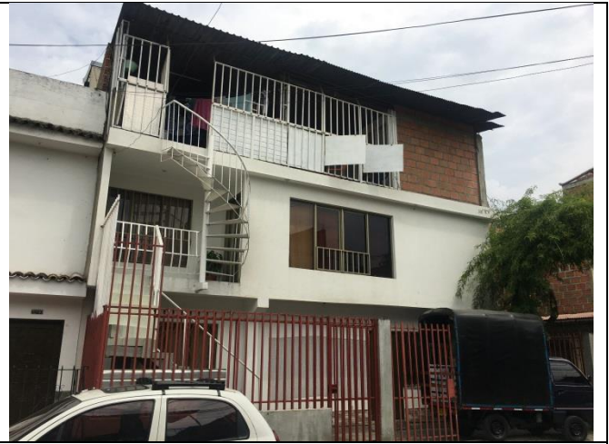
Fachada Carrera 1C2
