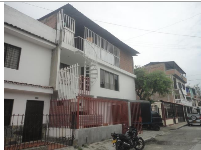
Fachada Carrera 1C2
