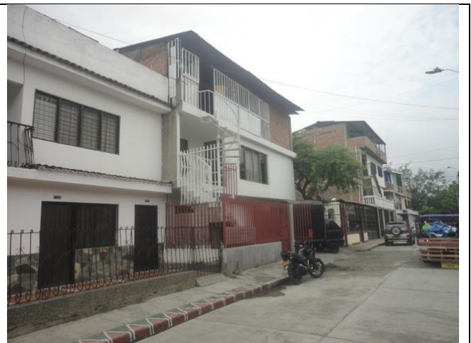
Fachada Carrera 1C2
