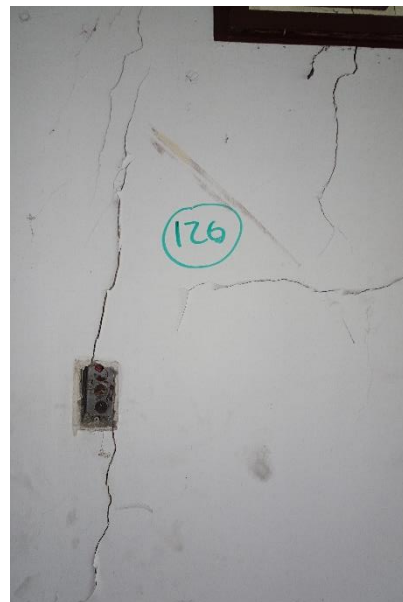
ESPACIO 126: Consultorio, grietas que atraviesan el muro. Comunes con el espacio 122, por acción de los asentamientos diferenciales.
