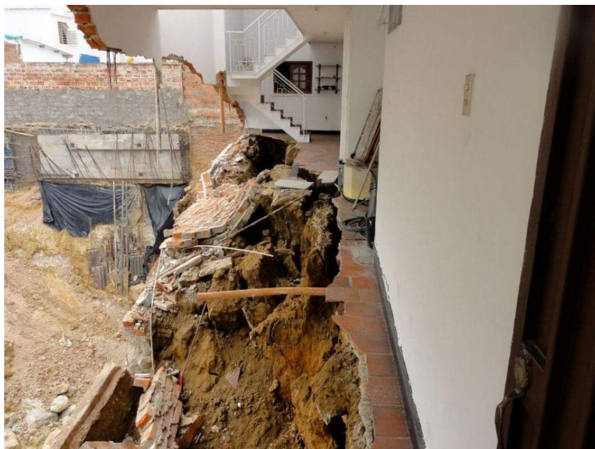
IMAGEN 14. ASPECTO INTERIOR DE LA CASA Y LA PROFUNDIDAD DE LA EXCAVACIÓN ASPECTO AL INTERIOR DE LA CASA (ENTRE EJES 1 Y 2, ESPACIOS 105,107 Y 109) Y LA PROFUNDIDAD DE LA EXCAVACIÓN VERTICAL (12.00 METROS) PARA LOS FUTUROS SÓTANOS DE GARAJES DEL EDIFICIO OPUS. Fuente: Familia Rey-Urbe.
