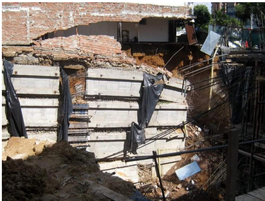
IMAGEN 13. DERRUMBAMIENTO DEL MURO CON EL DERRUMBAMIENTO DEL MURO LA CASA PIERDE SOPORTE Y DESESTABILIZA SU ESTRUCTURA PORTANTE. LOS CIMIENTOS QUEDAN SIN SOPORTE. Fuente: Familia Rey-Urbe.
