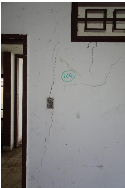
ESPACIO 126: Consultorio, grietas que atraviesan el muro. Comunes con el espacio 122, por acción de los asentamientos diferenciales.
