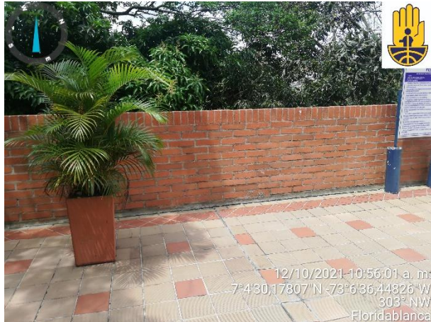
Imagen 28. muro en área de la piscina. Fuente propia
