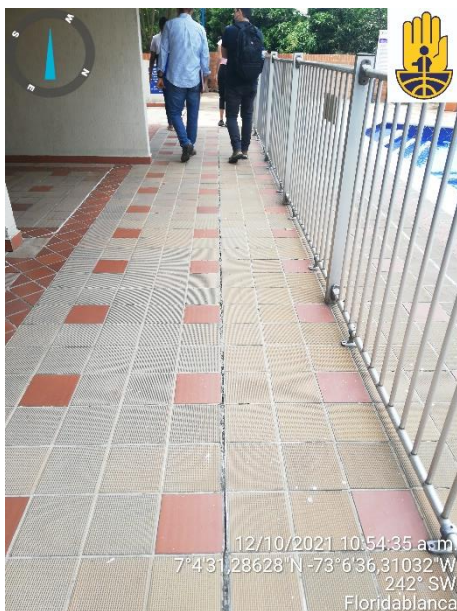
Imagen 26. Ingreso al área de la piscina. Fuente propia
