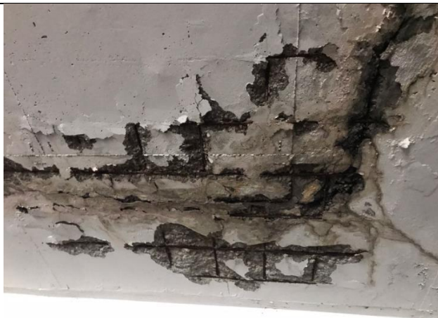
Imagen 3. Estado de la cimentación de la vivienda que solicita la visita. (Fuente: Propia)
