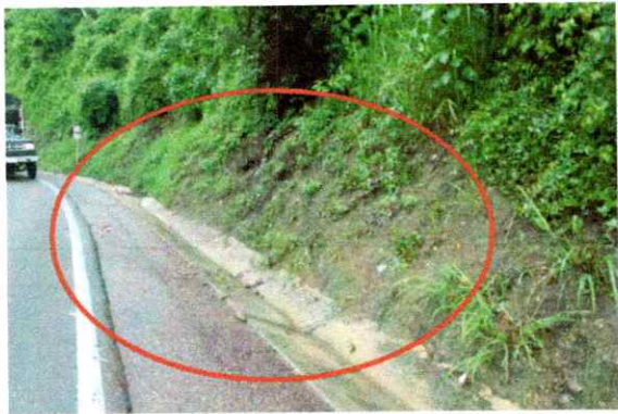
Foto 11. Foto Plano medio. Trozos de vidrio fragmentado sobre la parte verde, cuneta y berma, en el costado de la vía sentido San Alberto- Bucaramanga
