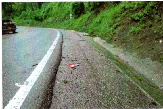
Foto 14 foto primer plano. Trozos de vidrio en la berma de la vía, sentido San Alberto Bucaramanga
