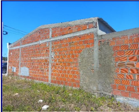
ESTRUCTURA Y MAMPOSTERIA
