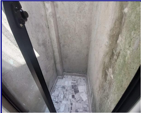
AREA LIBRE DUCTO DE VENTILACION
