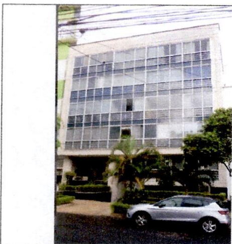
FACHADA DEL PREDIO OBJETO DE AVALÚO
