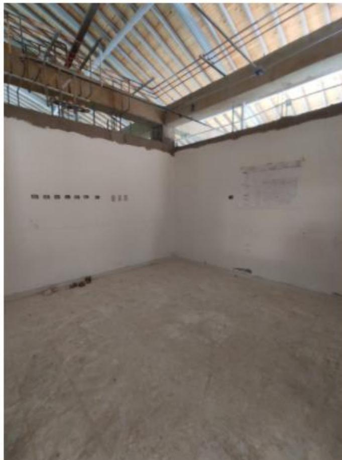
7. En obstetricia no hay ninguna salida de iluminación (tubería y caja)
