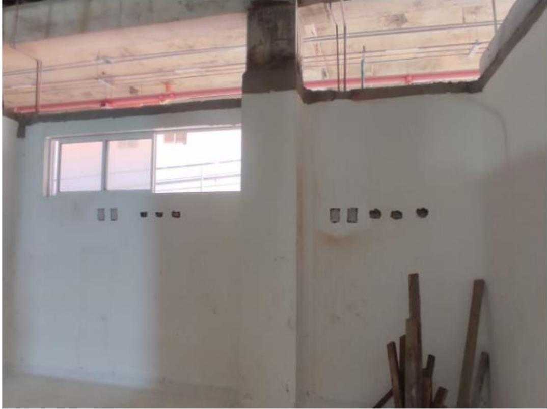
6. En el cuarto de sala de partos faltó instalar una toma que estaba la tubería por piso sin embargo esta se anuló por iniciativa propia del eléctrico mencionando que esta debía era ir por cielo y en ultimas la instalo en una pared, el daño causado al cuarto fue grande debido a que en los diseños marca por piso y se deben seguir los diseños lo cual implican arreglos constructivos en zona con piso de granito pulido.
