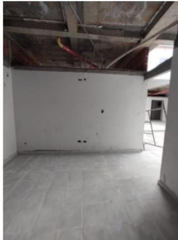
4. En los jardines secos falto por instalar cajas para salidas de iluminación de emergencia cerca a la entrada del pasillo intrahospitalario, por lo cual hay que romper muro completamente terminado.
