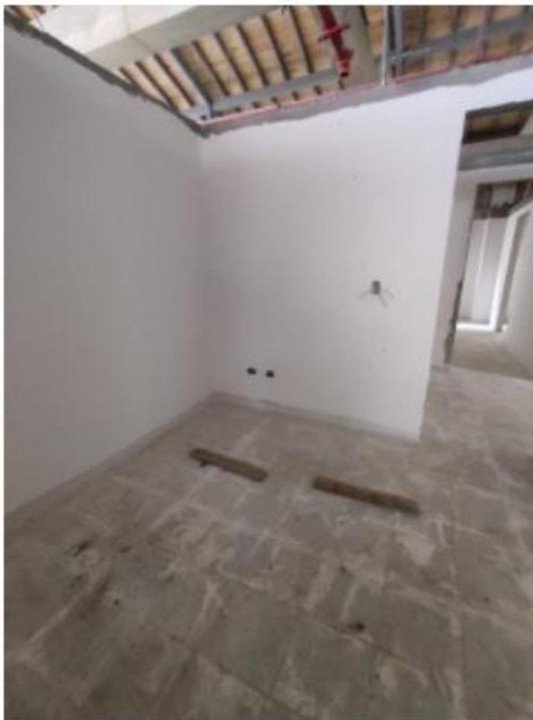
2. En el cuarto PyP se instalaron punto de tomas a 40 cm del piso sin embargo estas tres tomas deben ir a 150 cm del piso, por ende, se deben arreglar lo cual implica dañar muros completamente terminados
