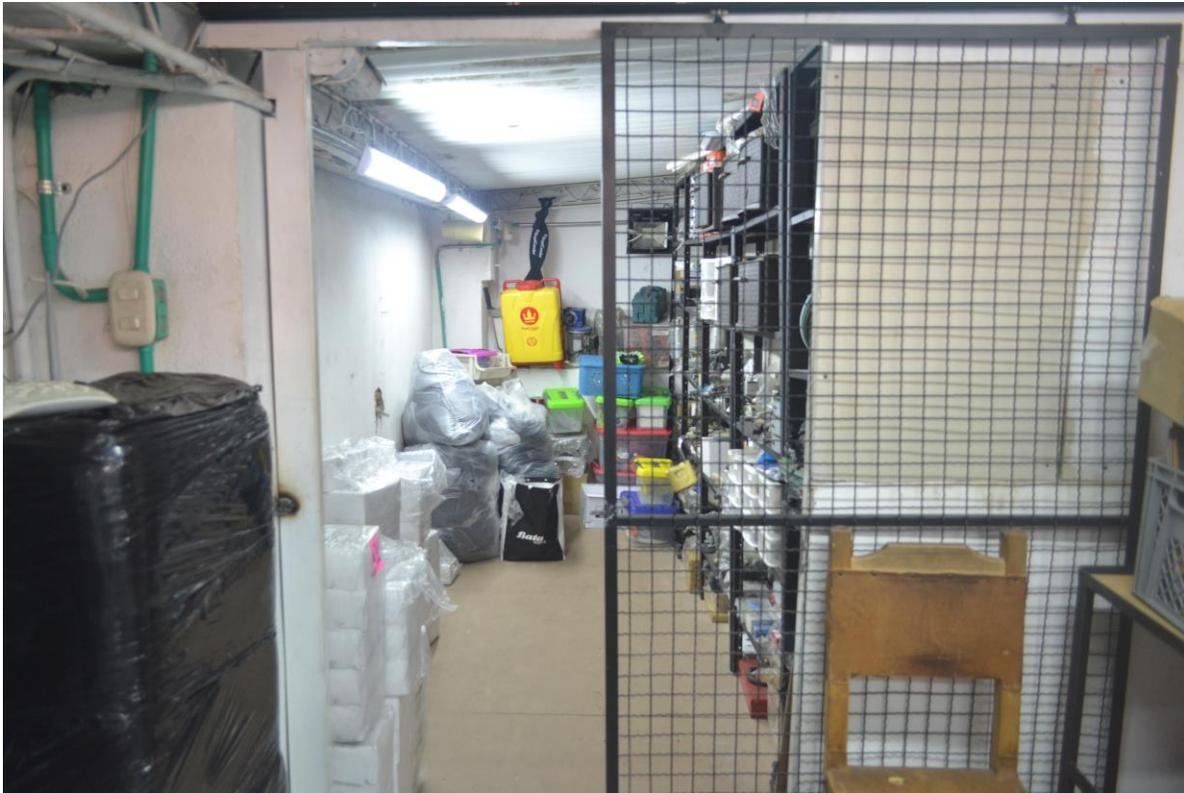
Rejas y paredes en draywall faci retiro al no estar sujeto a la construccion solo estan confinados o puestos a la vista
