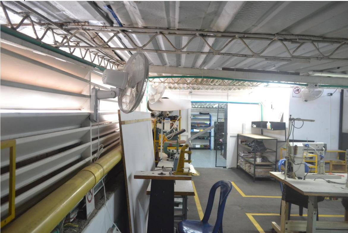
El techo en esta area es el mismo que contaba la edificacion la altura entre la placa del mezanine con el techo presnta un altura mnima lo que hace que esta area se haga sofocante por las condiciones de altura .alta temperatura por la clase de teja termo acustica.
