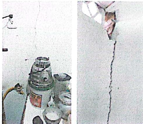
En las imágenes se muestra que las grietas ya son tan profundas que se puede apreciar los rayos de luz a través de los muros, es decir no es un simple vencimiento superficial, es una grieta que atraviesa el muro de lado a lado
