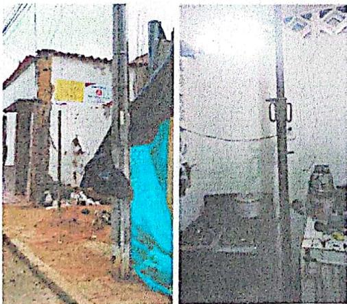
En la imagen de la izquierda se puede observar la obra de construcción que linda con la edificación en estudio, por el costado oriental, que es el costado afectado por la falla de los muros.
