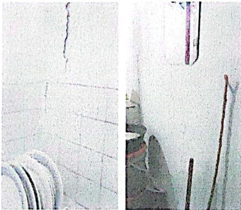
El desprendimiento del muro posterior se presenta en diferentes puntos, evidenciando su inclinación en la intersección con los muros longitudinales. También se presentan otras grietas verticales y horizontales lo que da un aviso temprano que el muro ya se encuentra fragmentado y en evidente riesgo de colapso.
