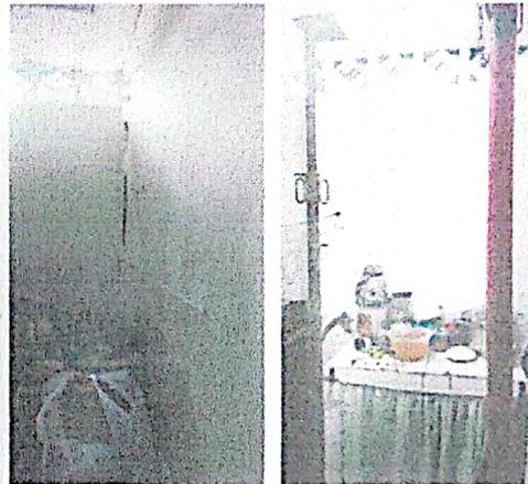
En la imagen de la izquierda se observa claramente que el muro colindante con la edificación en construcción se desplazó y presenta inclinación hacia el costado derecho.
