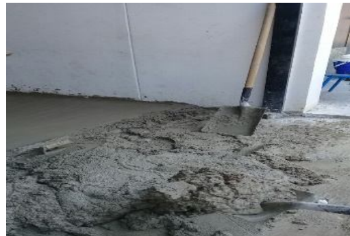
Fundida de una nueva placa en concreto endurecido
