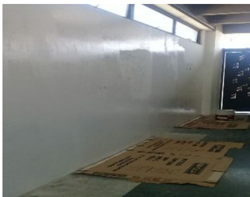
Aplicación de pintura sobre muros exteriores resanados
