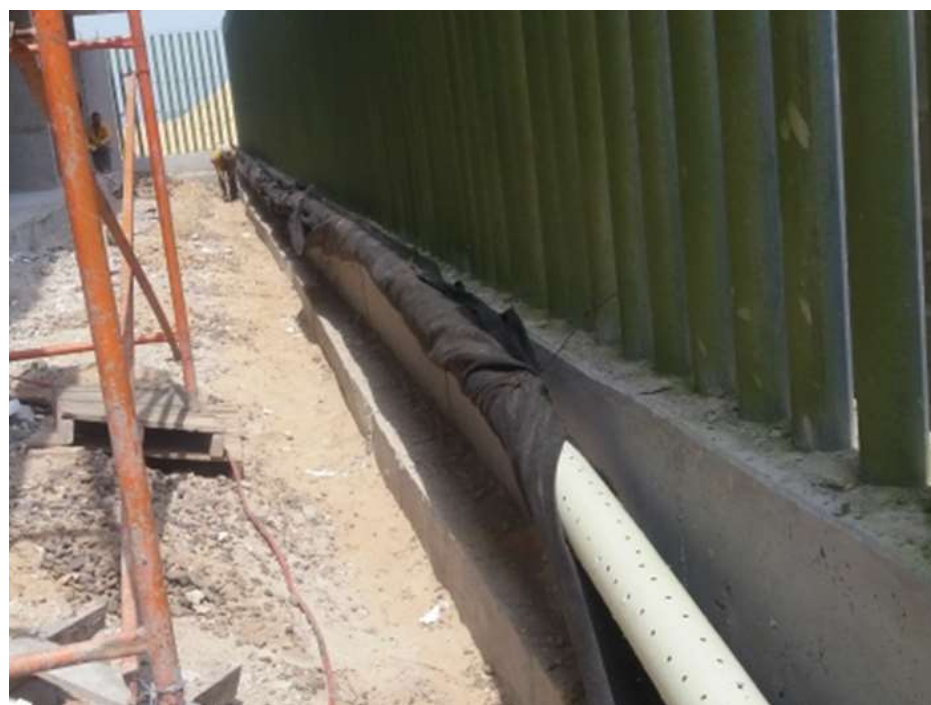
INSTALACIÓN DE TUBERÍA DE DRENAJE SEGÚN RECOMENDACIÓN DEL ARQUITECTO JAIME CABAL
