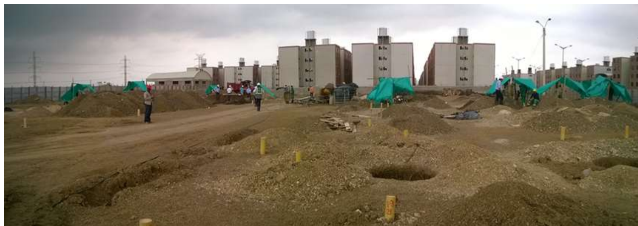
PROCESO DE EXCAVACIONES PARA CIMENTACIÓN PROFUNDA CON CAISSONS
