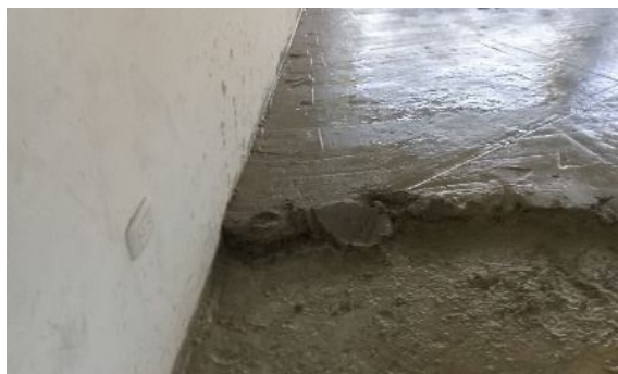
Fundida de una nueva placa en concreto endurecido
