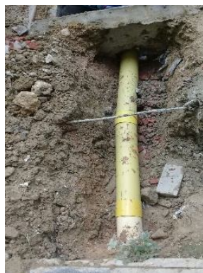
Reparación de la tubería de desagüe y reinstalación del sanitario
