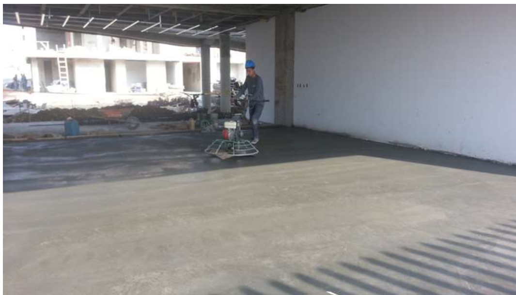
ACABADO FINAL DEL CONCRETO, CON MÁQUINA DE ASPAS METÁLICAS
