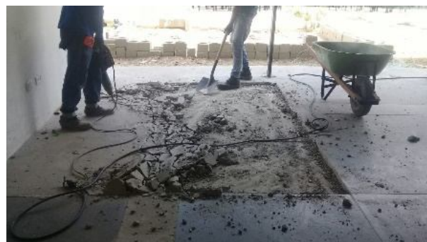
Demolición de placa fisurada
