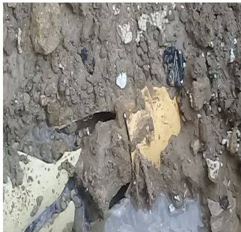
Estado del sanitario y hallazgo de la fisura en la tubería de desagüe.
