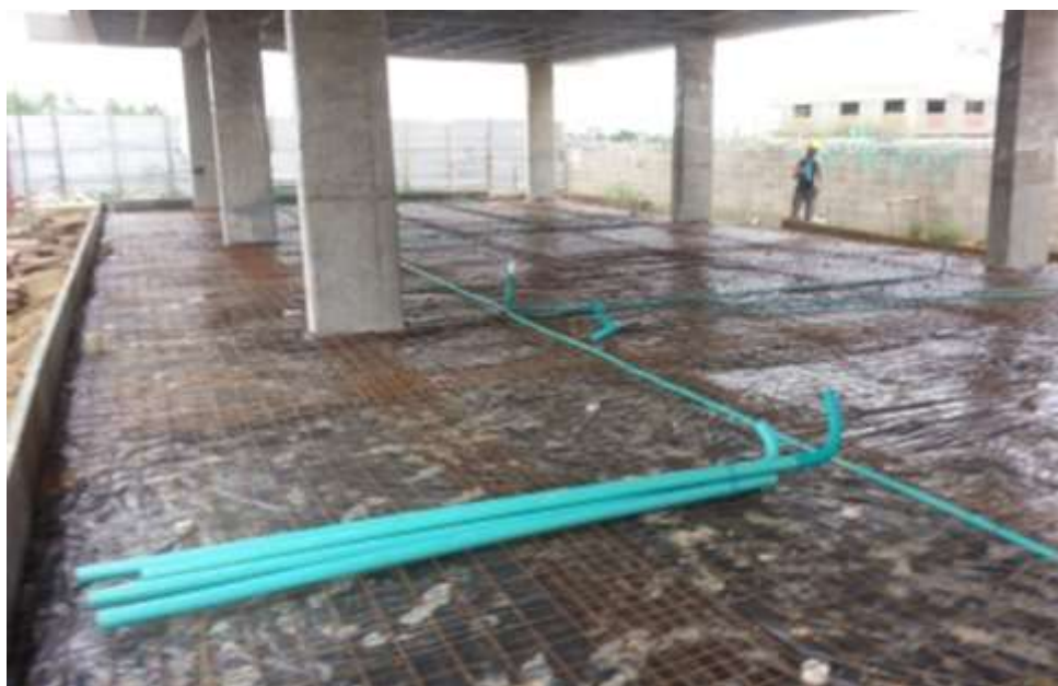
INSTALACION DE POLIETILENO DE AISLAMIENTO SOBRE EL RECEBO COMPACTADO, COLOCACIÓN DE LA MALLA ELECTROSOLDADA COMO REFUERZO ESTRUCTURAL DE LA PLACA DE CONTRAPISO.
