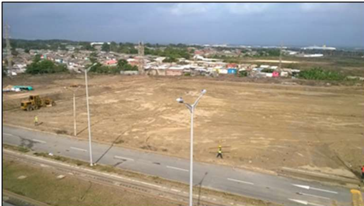
ESTADO DEL TERRENO DESPUES DE REALIZAR EL MOVIMIENTO DE TIERRA, PARA LOGRAR EL NIVEL DEL PROYECTO INDICADO EN PLANOS
