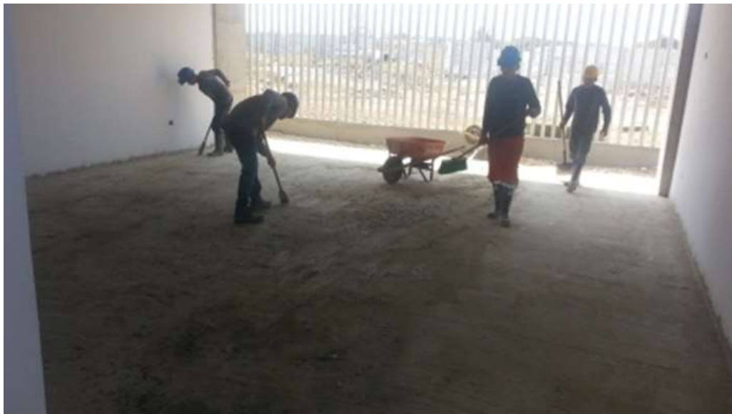
PREPARACIÓN DE LA PLACA DE CONTRAPISO PARA FUNDIDA DEL CONCRETO ENDURECIDO Y ACABADO CON HELICÓPTERO
