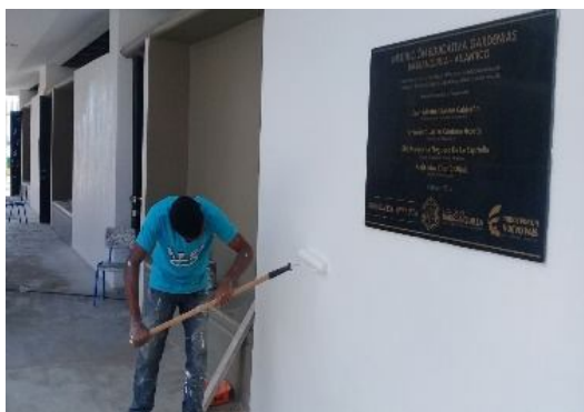
Aplicación de pintura sobre muros exteriores resanados
