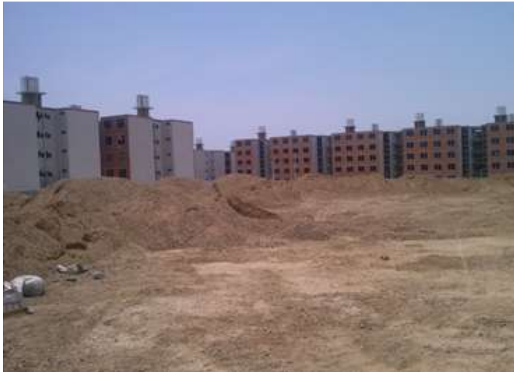
Fotografía 1. Vista general del lote en estudio
