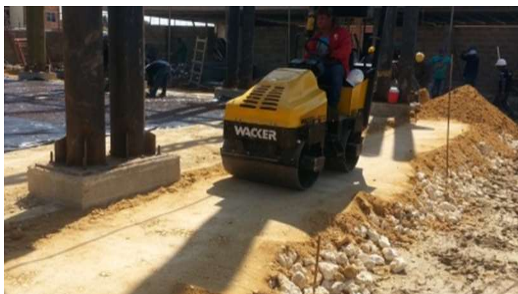
PROCESO DE COMPACTACIÓN DEL RECEBO TIPO IDU
