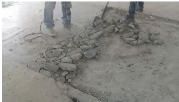
Demolición de placa fisurada
