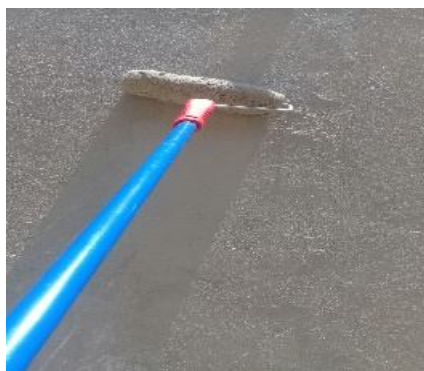
Aplicación de pintura sobre muros exteriores resanados
