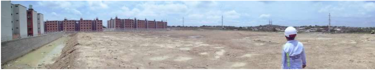
Fotografía 7. Vista general del lote de estudio.
