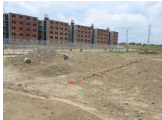
Grietas sobre el material superficial del lleno
