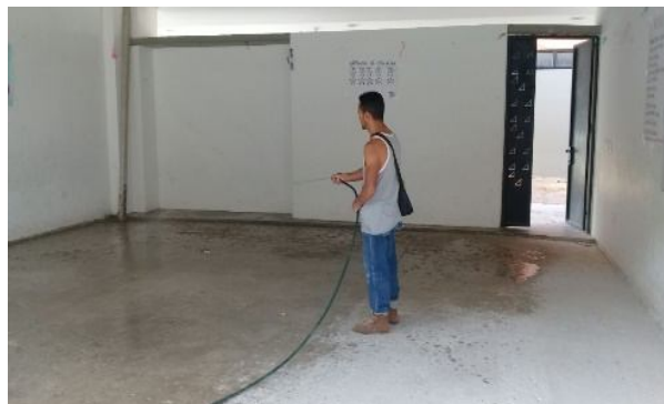
Proceso de curado, pulida y brillada de la nueva placa en concreto endurecido
