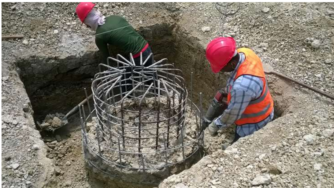
PROCESO CONSTRUCCIÓN CIMENTACIÓN PROFUNDA, CON CAISSONS A 5.00 M DE PROFUNDIDAD
