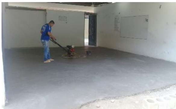
Proceso de curado, pulida y brillada de la nueva placa en concreto endurecido
