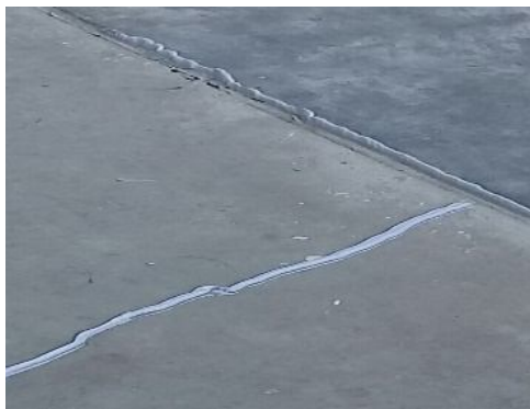
Aplicación de sello plástico en fisuras de placas de piso
