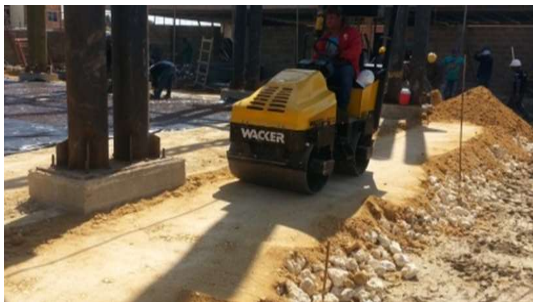
PROCESO DE COMPACTACIÓN DEL RECEBO TIPO IDU
