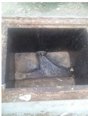
Reparación de la tubería de desagüe y reinstalación del sanitario
