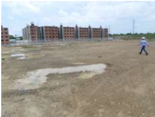
Acumulación de aguas meteóricas sobre el terreno – malas condiciones de drenaje
