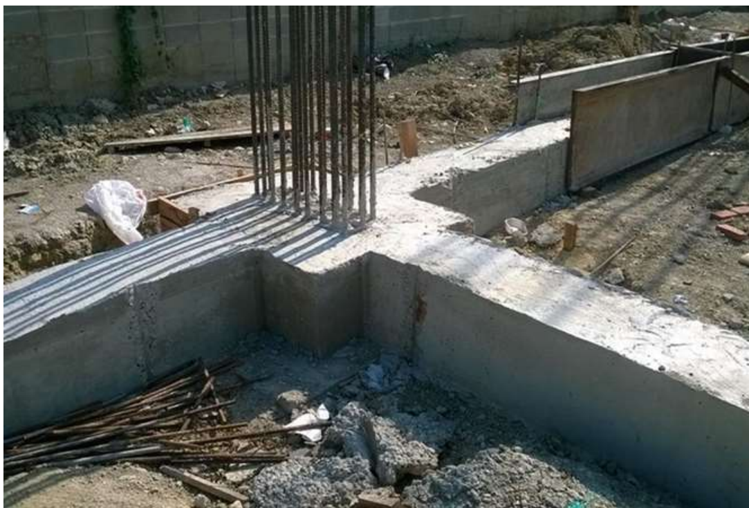
VIGAS DE AMARRE DE CIMENTACIÓN EN CONCRETO ARMADO QUE CONFINARÁN LA PLACA DE CONTRAPISO
