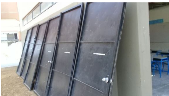
Desmonte de puertas metálicas para ajuste de bisagras
