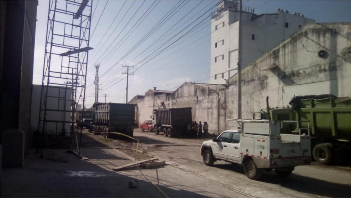
Imagen 10: donde se evidencia que el andamio se encuentra dentro de una distancia de separación de Max 2mts.
