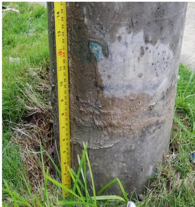
Imagen 7: medidas 30 cm por fuera de línea de seguridad de empotramiento del poste.
