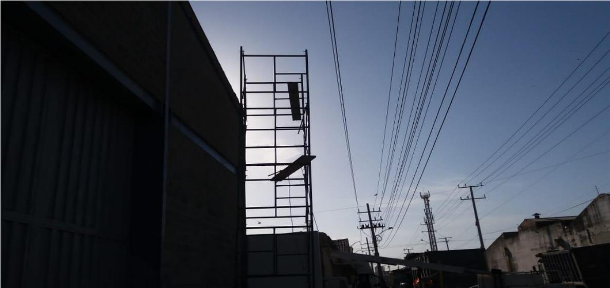
Imagen 8: ubicación del andamio inmediatamente después del accidente, donde se ve la cercanía de la línea y el desplome del circuito
