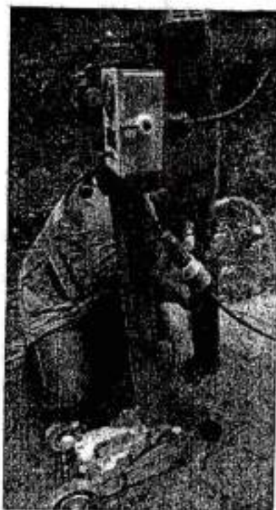
FOTO 5. Extracción de Núcleo para prueba a compresión.
