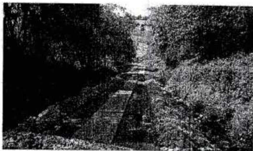
FOTO 6. Demolición tramo afectado.
