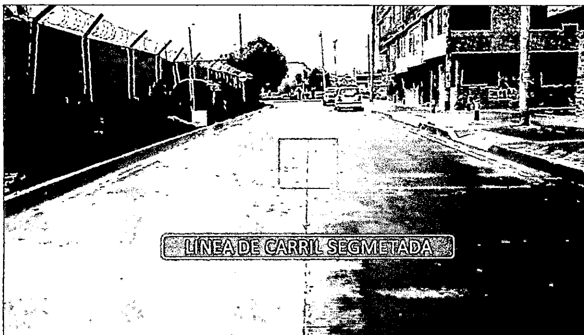
IMAGEN 7. En la imagen en el costado medio de la vía, línea segmentada de carril blanca.
